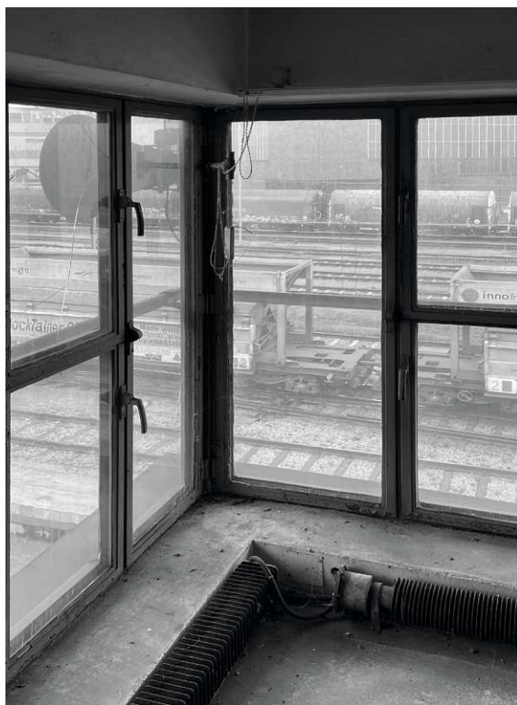
Abb. 134 Regelfenster auf Holz von Innen
