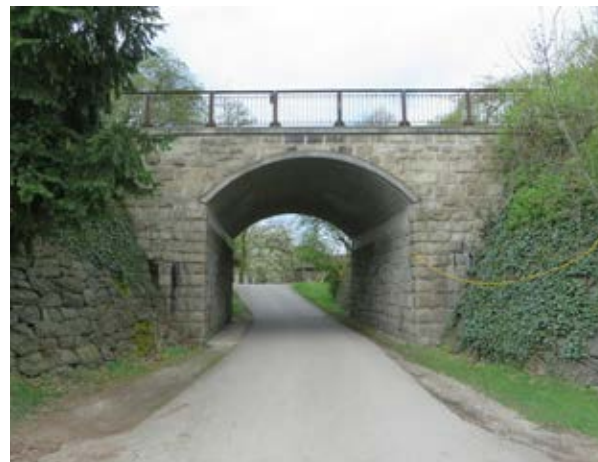
Abb. 70: Unterführung der Rechten Brückenstraße ②
