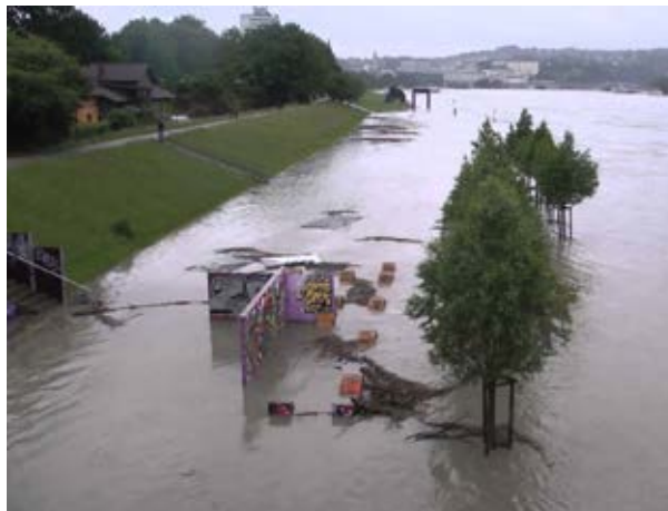
Abb. 81: Hochwasser 2013, Donauzugang Bau- platz
