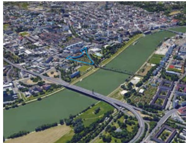
Abb. 58: Blick auf das Grundstück
