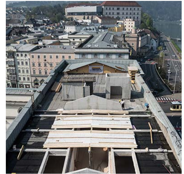
Abb. 42: Sanierungsarbeiten am Hauptgebäude der Kunstuniversität
