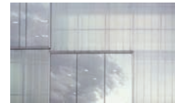
Abb. 142: Transparente & opake Fassadenelemente
