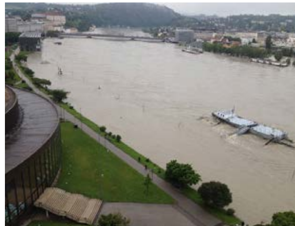
Abb. 82: Hochwasser 2013, Blick Richtung Nibelungenbrücke
