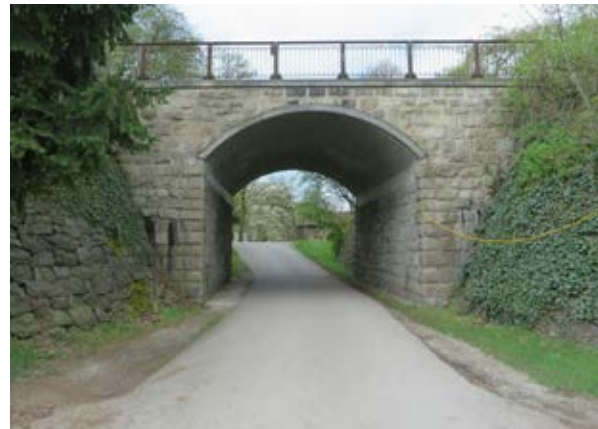
Abb. 105: Unterführung Rechte Brückenstraße ②
