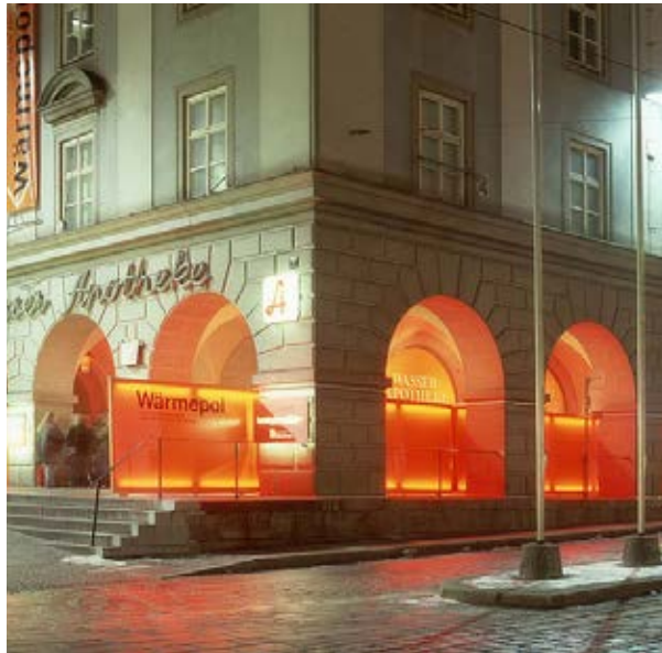
Abb. 40: Wärmepol im Hauptgebäude der Kunstuniversität Linz
