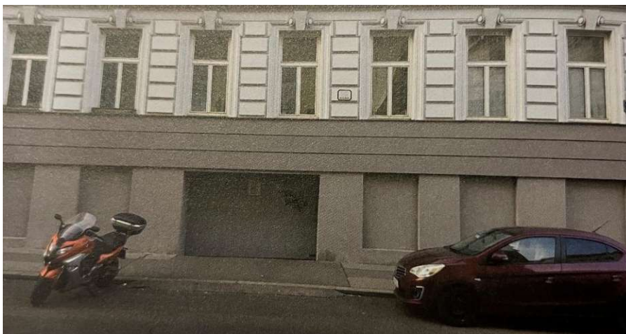
Abbildung 5: Verschlussene Erdgeschoßzone im gründerzeitlichen Stadthaus. Quelle: Psenner (2023), S. 108
