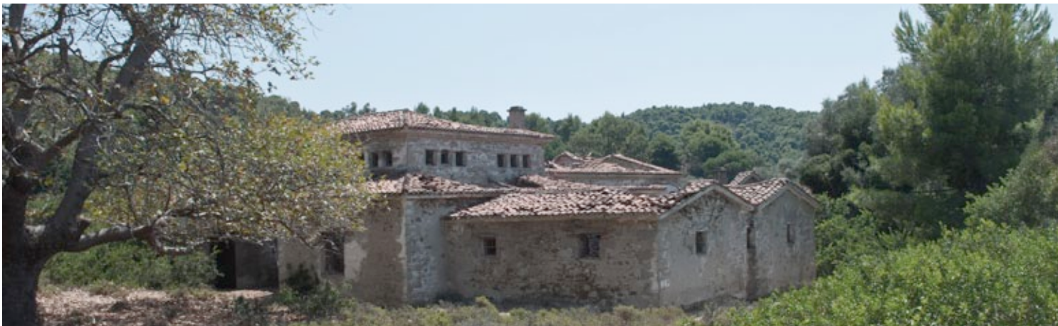
Abb. 08: Nordwestfassade der Olivenölpresse
