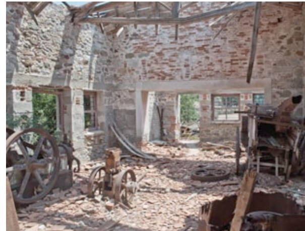
Abb. 32: Blick vom Maschinenraum Richtung Süden
