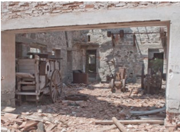
Abb. 31: Blick vom Vorraum zum Maschinenraum
