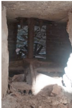
Abb. 22: Antrieb des Kollergangs
