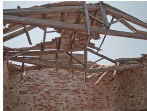
Abb. 38: Dach des Maschinenraumes
