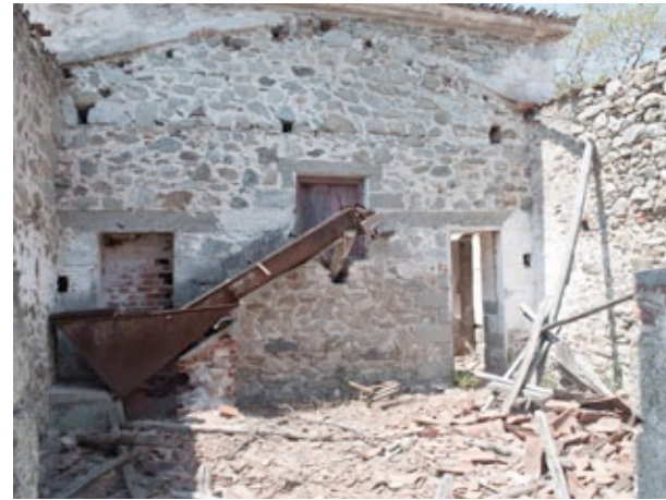
Abb. 27: Lagerraum für Oliven mit Rinne zum Kollergang
