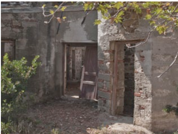
Abb. 37: Eingänge der Nordseite
