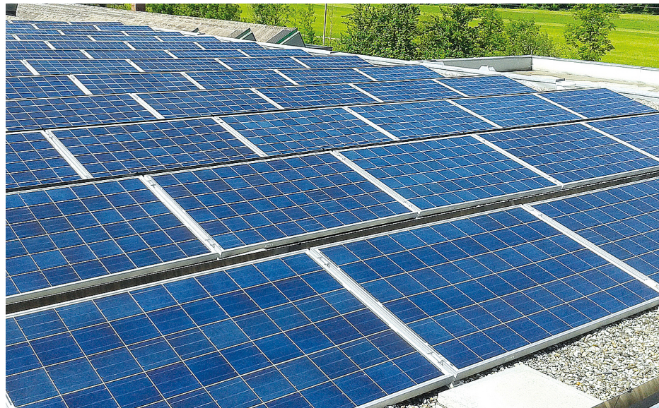
Abb. 6.2: Installation von Photovoltaik auf einem Flachdach
