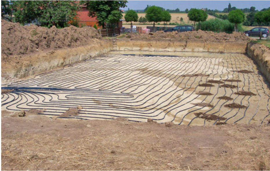
Abb. 7.11: Verlegung von Erdwärmekollektoren
