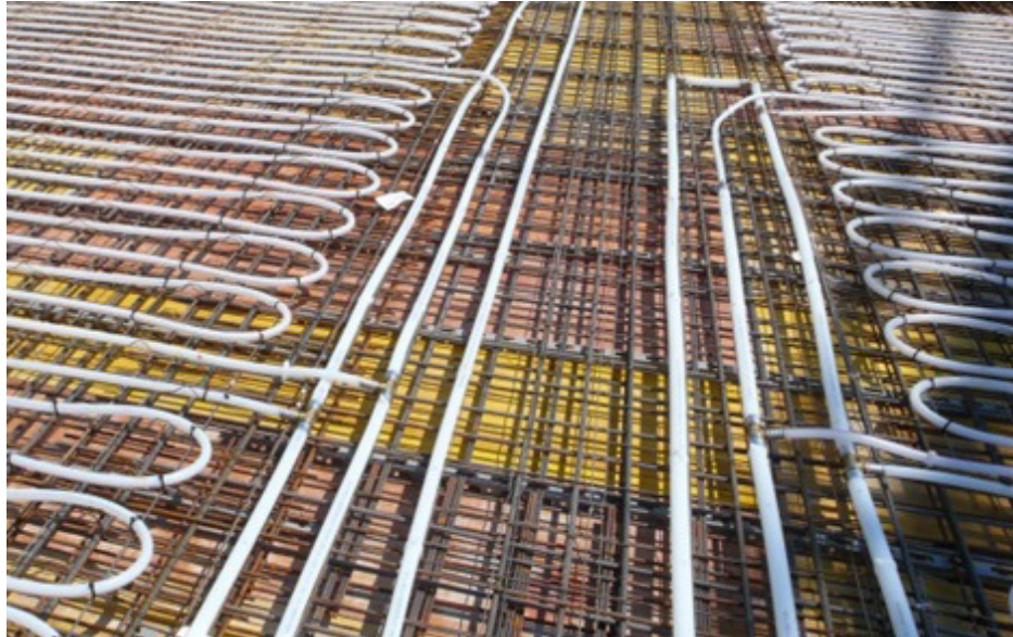
Abb. 9.7: Verlegung der Rohrleitung für die Bauteilaktivierung
