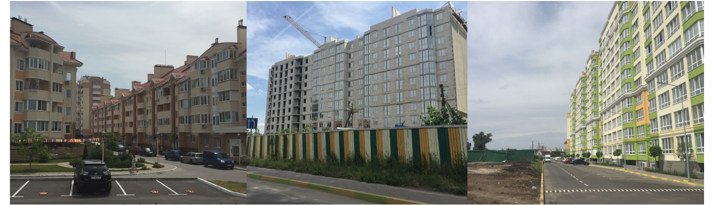
Wohnsiedlungen in der Nähe von Kiew
