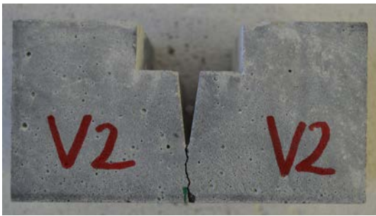
Abbildung 6.8: Rissbild V2 mit h_{lig} = 2 \text{ cm} - zulässiger Rissverlauf
