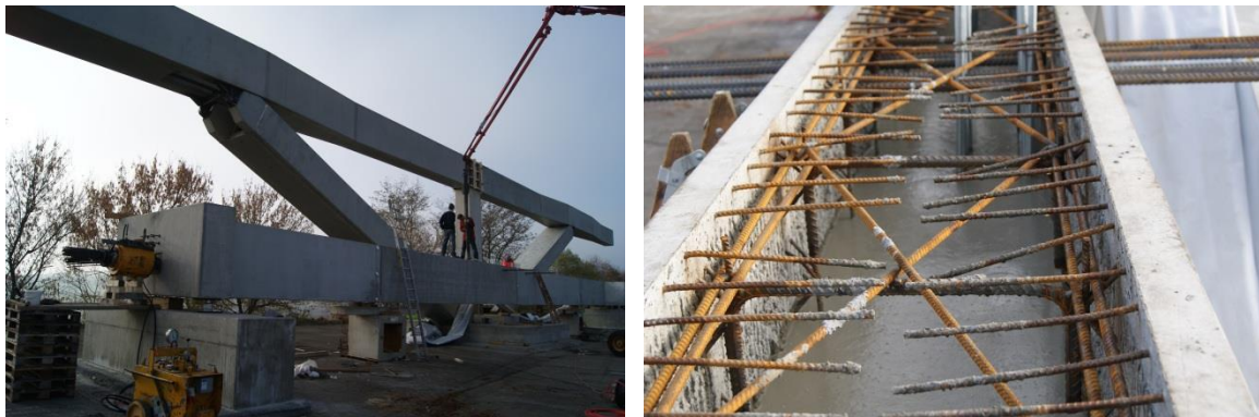
Abbildung III-7: Vorspannen des Einfeld-Brückenstegs
