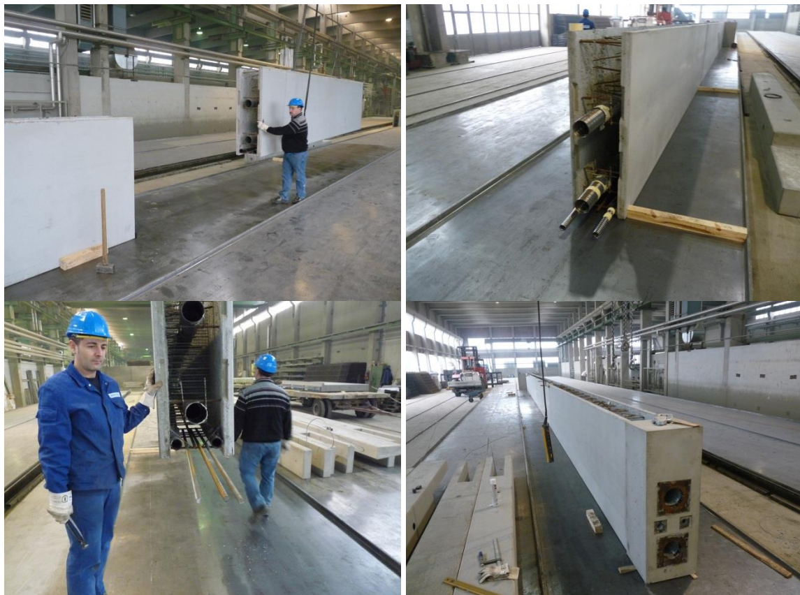
Abbildung II-48: Zusammenstellen der Doppelwandelemente im Fertigteilwerk
