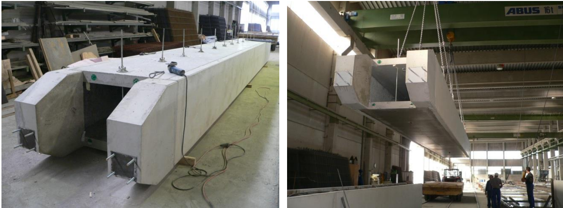
Abbildung II-13: Verladen der fertigen Druckstrebe
