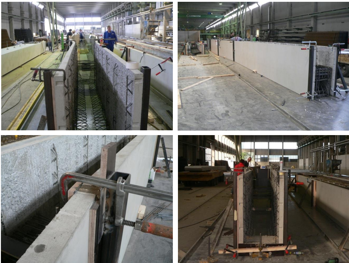
Abbildung II-5: Aufstellen der Wandelemente auf dem Schaltisch – Abschalen der Stoßfugen und Trägereenden
