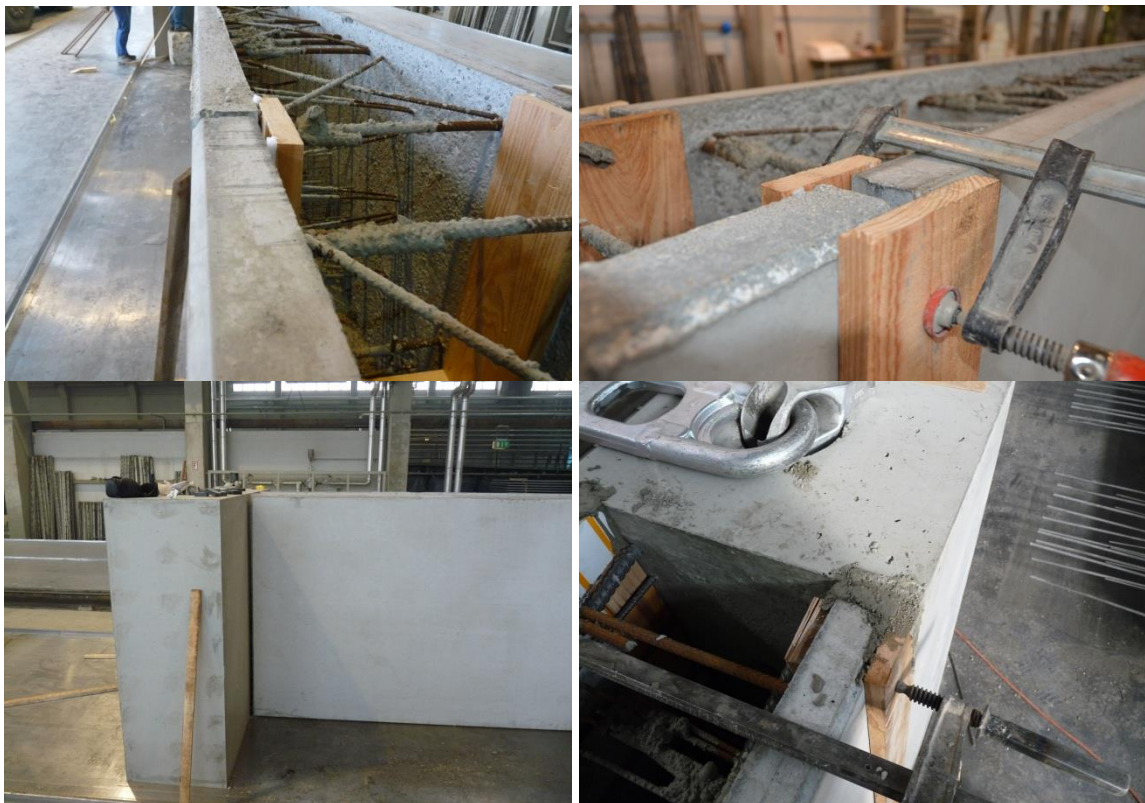
Abbildung II-49: Abschalung der Stoßfugen und Verfüllen mit Vergussmörtel
