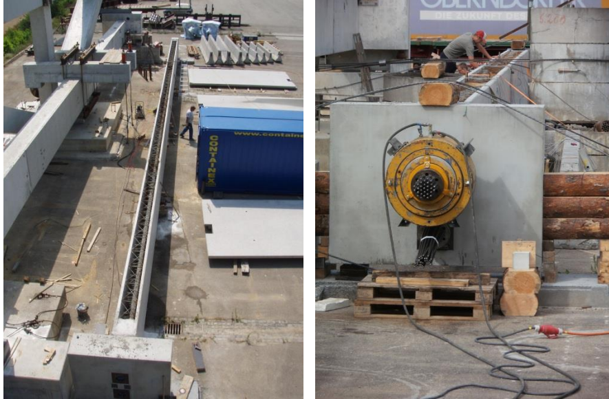
Abbildung III-80: links: Versuchsträger am Versuchsgelände – rechts: Versuchsträger nach Einbau der Spannlieder, Spannpressen und Sicherungslitzen gegen schlagartiges Ausweichen der Elemente
