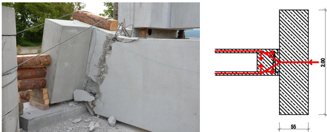
Abbildung III-85: Versagensstelle Versuchsträger 1 – Versagensmodell der Krafteinleitungsstelle
