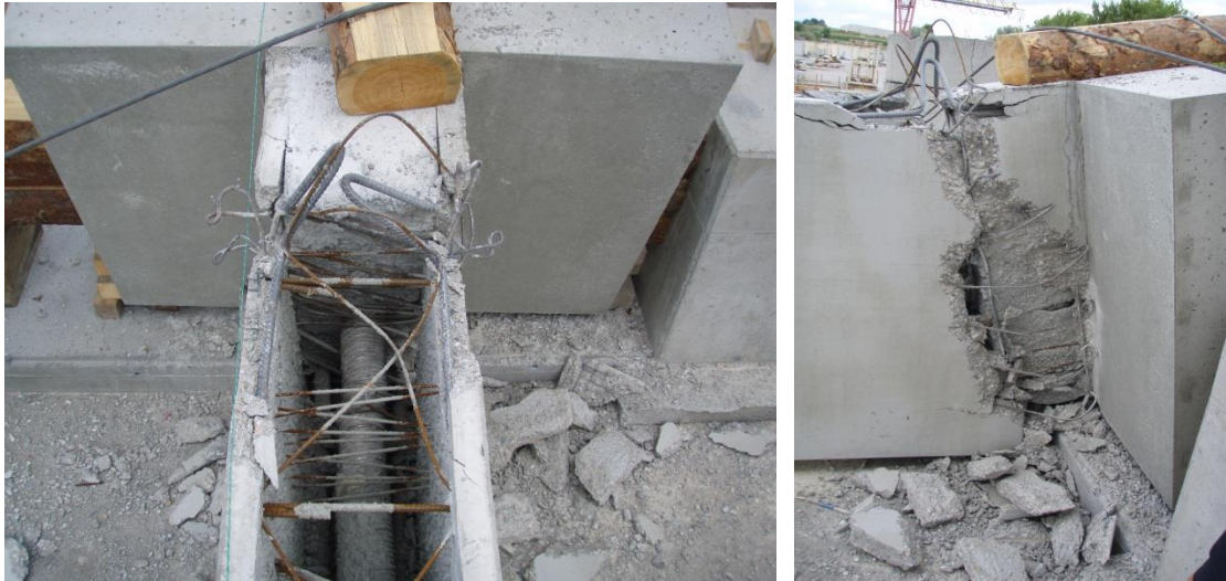
Abbildung III-86: Versagen der Lasteinleitungsstelle- Versuchsträger 1
