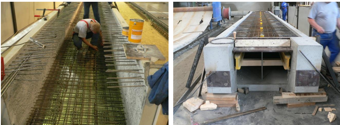
Abbildung II-12: Verlegen der Bewehrung von unterer und oberer Platte
