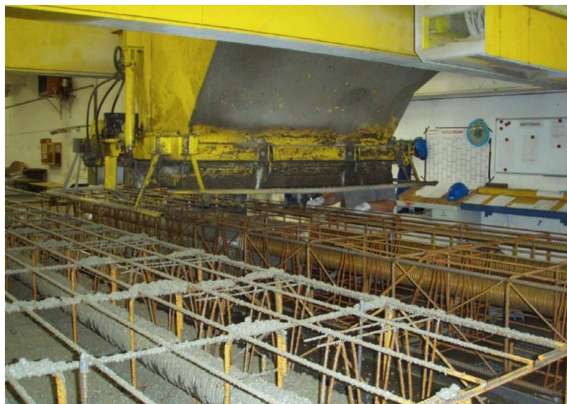
Abbildung II-38: Betonieren der 1. Halbschale der Doppelwandelemente
