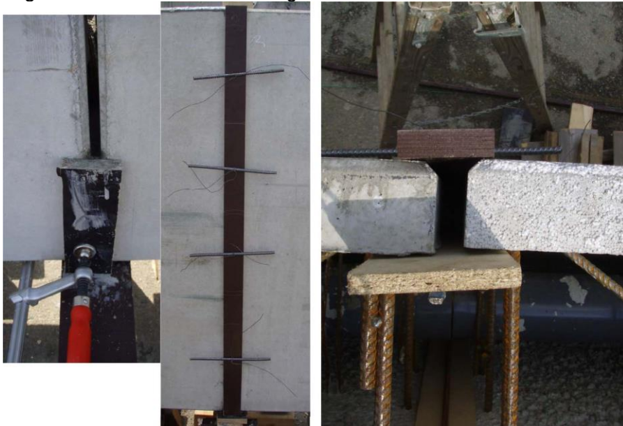
Abbildung II-45: Abschalung der Elementfugen – links: Abschalung Bodenplatte – Mitte, rechts: Fugenabschalung
