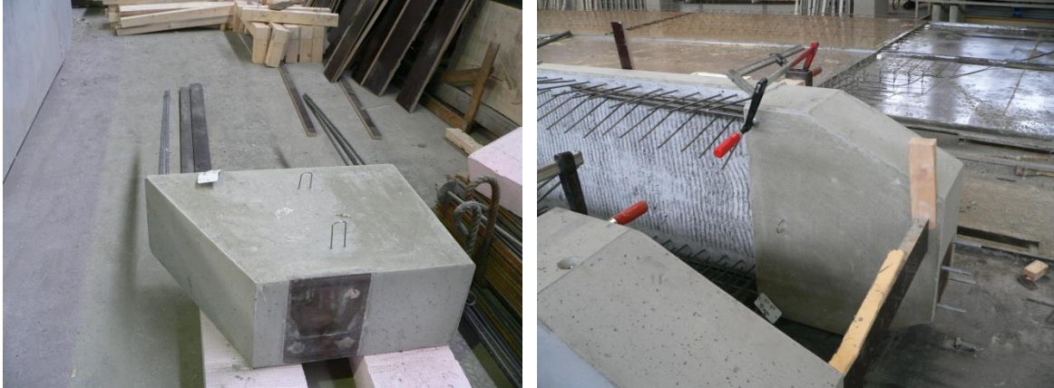
Abbildung II-11: Lasteinleitungsblock – Aufgestellte Seitenwangen mit einbetoniertem Lasteinleitungsblock
