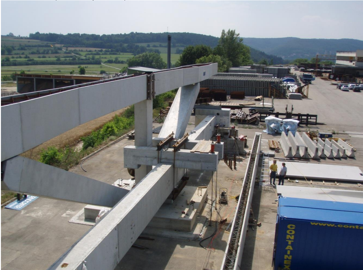
Abbildung I-16: Versuchsgelände Fa. Oberndorfer in Gars am Kamp – Klappbrücke aus Fertigteilen hergestellt aus Gitterträgerdecken(l) - Ausbetonierter Fertigteilträger aus Gitterträgerdecken (m) – Versuchsträger aus Doppelwandelementen (r)
