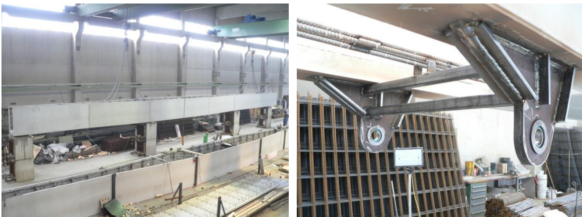
Abbildung II-8: Herstellen der Knotenverbindung für den Anschluss der Druckstreben
