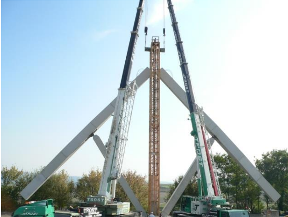
Abbildung I-17: Absenken der trogförmigen Fertigteilträger mit dem Brückenklappverfahren
