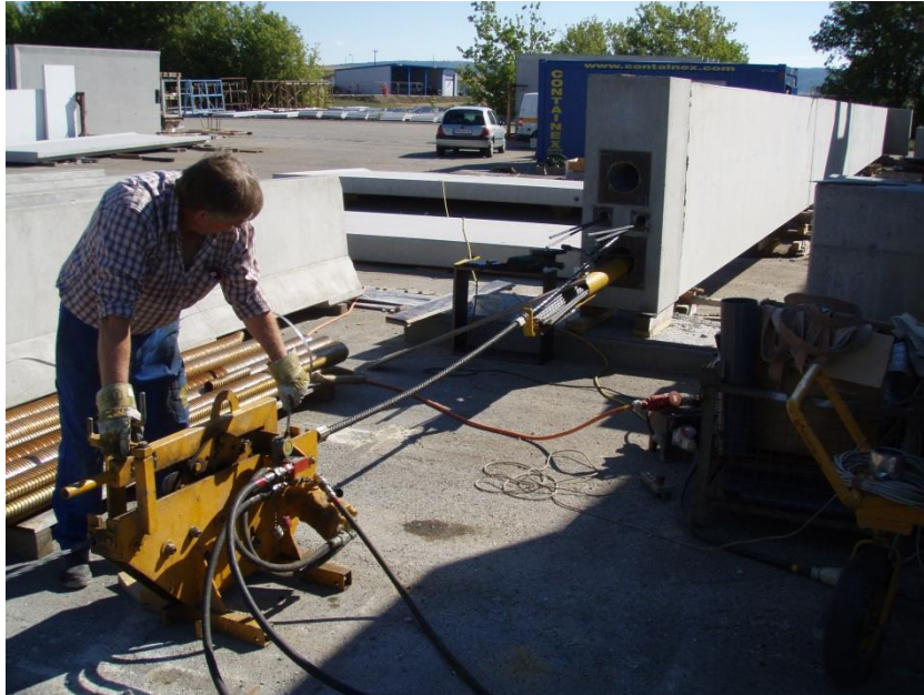
Abbildung II-47: Einbau der Spannglieder
