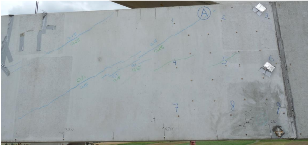
Abbildung III-62: Risse in der Vorderseite der linken Versuchsträgerhälfte - Laststufe 1.075 kNm nach 115 Minuten
