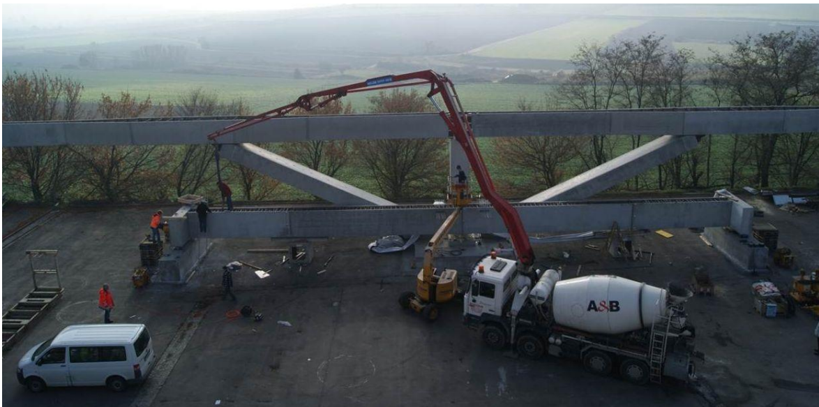
Abbildung III-1: Ausbetonieren eines 30 m langen trogförmigen Fertigteilträgers aus Elementdecken
