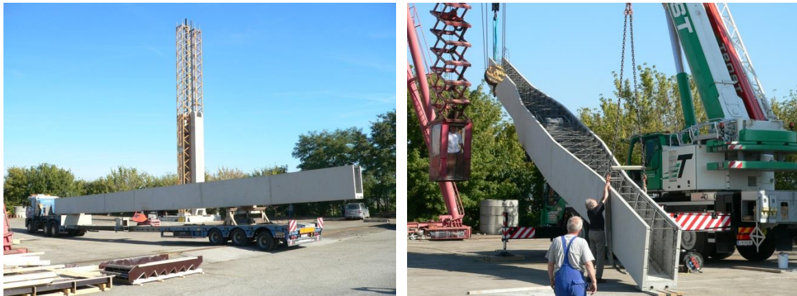
Abbildung II-9: Anlieferung des Brückenträgers – Einheben des Brückenträgers
