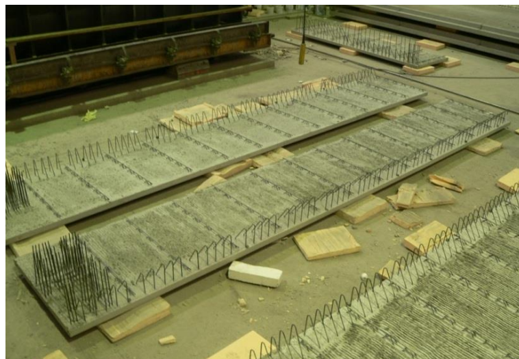
Abbildung II-4: Herstellung der Seitenwände aus Elementdecken
