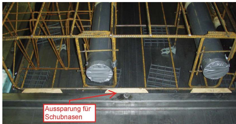
Abbildung II-37: Schalungselement für Schubnasen
