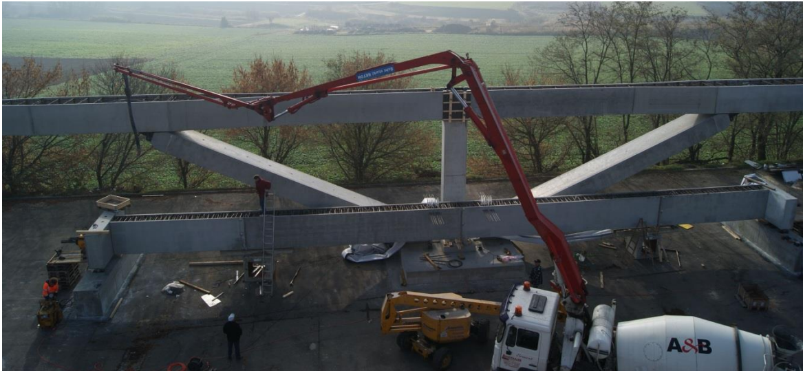
Abbildung II-24: 30 m langer vorgespannter, trögförmiger Fertigteilträger
