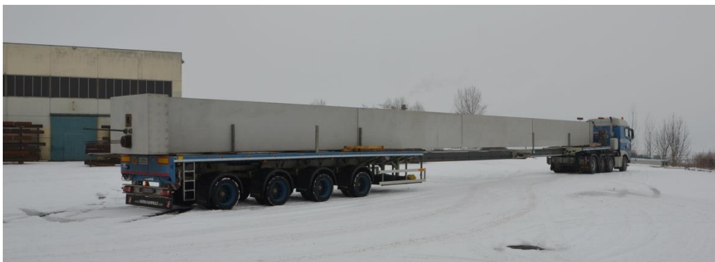
Abbildung II-53: Transport des Fertigteilträgers
