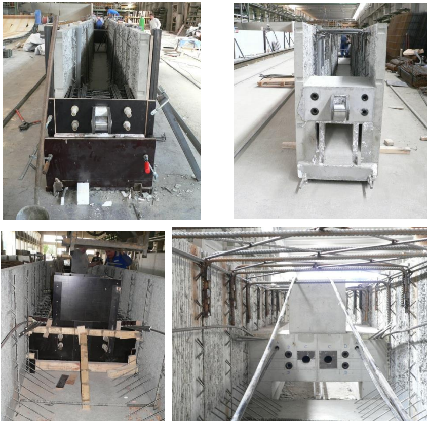
Abbildung II-6: Schalen der Querträger, Stegverstärkung und Umlenkstellen – Bauteile nach dem Ausschalen
