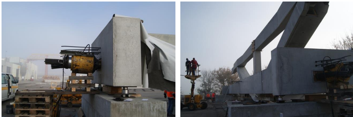
Abbildung II-23: Vorspannen des Einfeld-Brückensteigs
