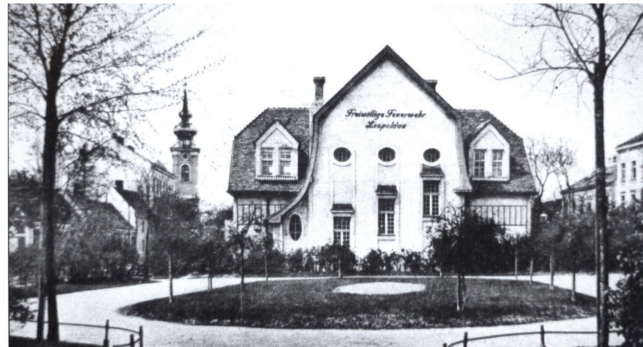
Abb. 53 Ansicht Feuerwehrhaus Richtung Kirche
