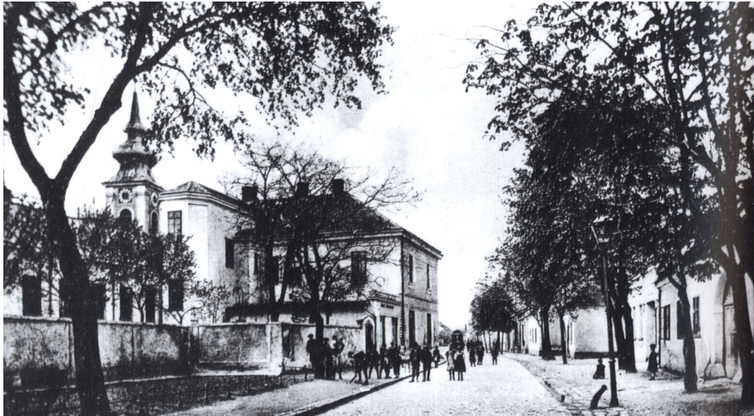
Abb. 43 Straßenzug nach Abbruch des Wirtschaftsgebäudes. ca. 1920
