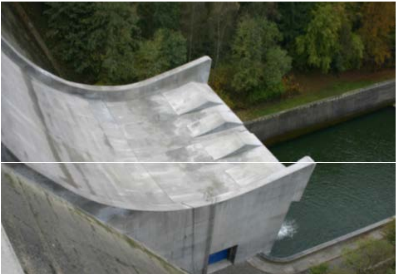
Abb. 85: HWE und Krafthaus nach Fertigstellung (17 Hartung, 1972)
