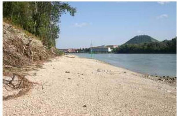
*Bereits kurz nach dem Rückbau entwickelte sich ein natürliches Donauufer*
