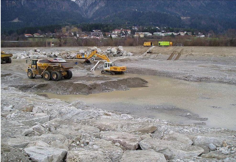
Bild 3. 26 Beispiel für eine Sohlpanzerung (Quelle: tirol.gv.at, Februar 2015)
