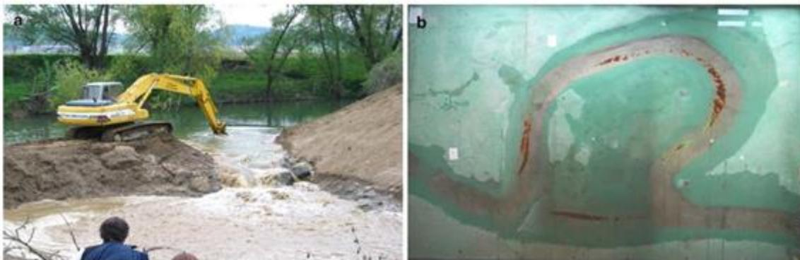
Bild 3. 24 a. Mäanderwiederanbindung an der Raab, Öffnung des Einlaufbereiches, b. Sedimentationsbereiche aus Modellversuch, dunkle Bereiche. (Quelle: Maßnahmen für einen modernen Flussbau betreffend Sohlstabilisierung und Flussrückbau, Springer – Verlag 2012)
