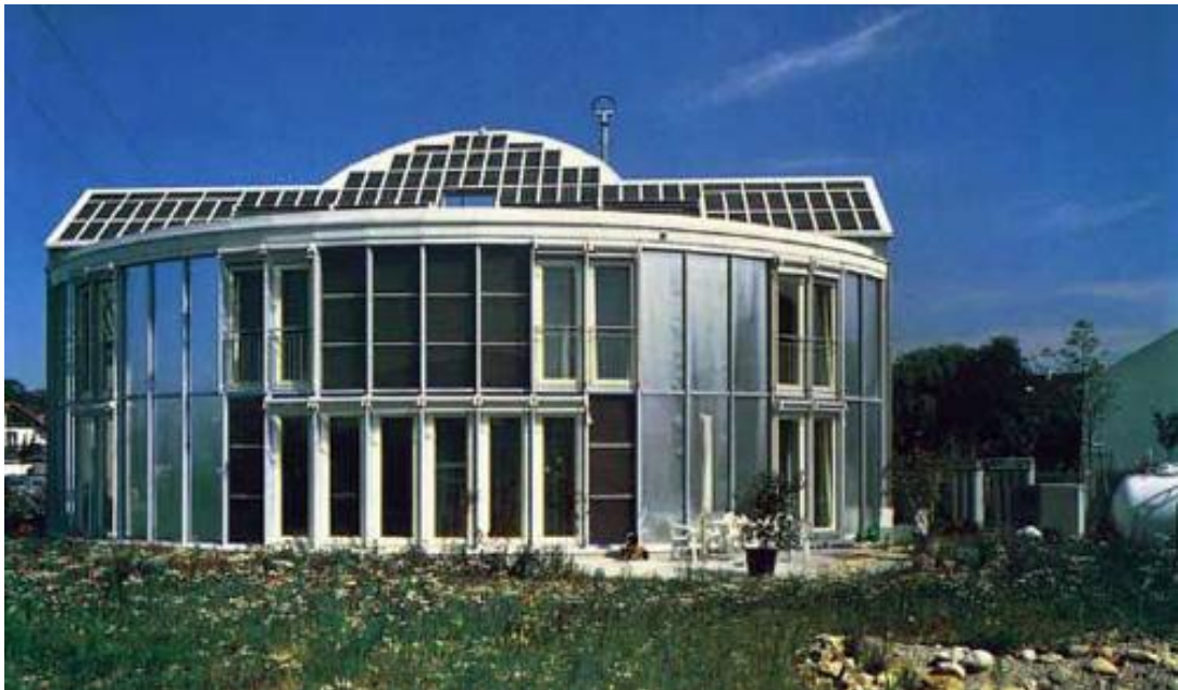
Abbildung 14: Energieautarkes Solarhaus in Freiburg, 1992 (Schoof, www.detail.de , 2011)
