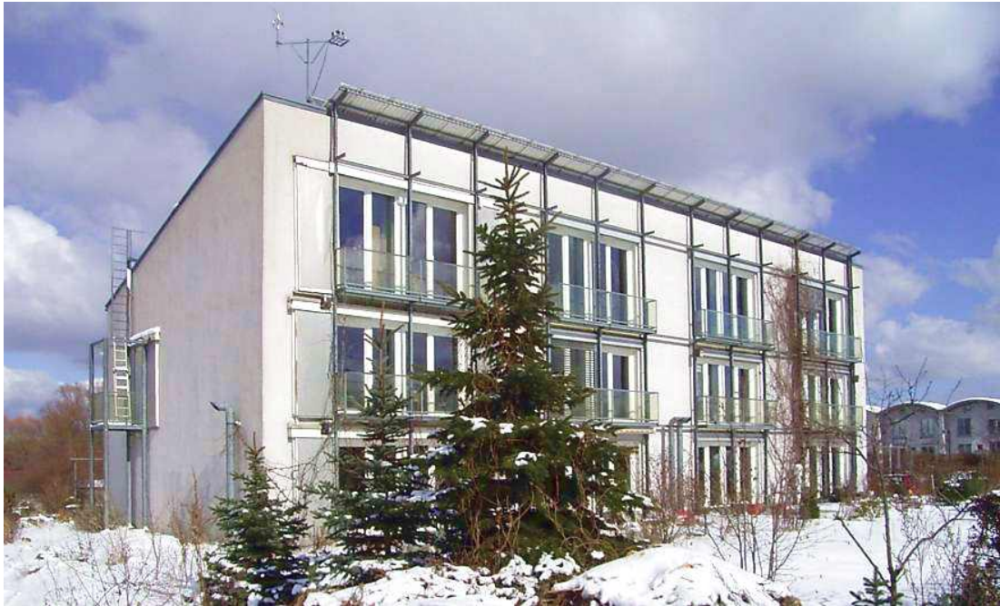
Abbildung 7: Das erste Passivhaus, Darmstadt-Kranichstein, 1991 ( www.passiv.de , 5.12.15)
