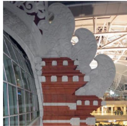
179-181 Der für Bali typische rote Sandstein (*paras*) wird im Flughafengebäude bewusst eingesetzt, um eine Verbindung zur lokalen Bautradition herzustellen
