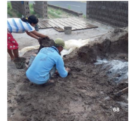
68-70 Lehmziegeln werden in Holzmodellen geformt und später an der Sonne getrocknet, Ziegelmanufaktur in Yogyakarta
