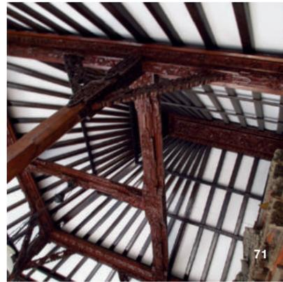
71-73 Holztragwerk und Dachkonstruktion eines traditionellen bales in Ubud
