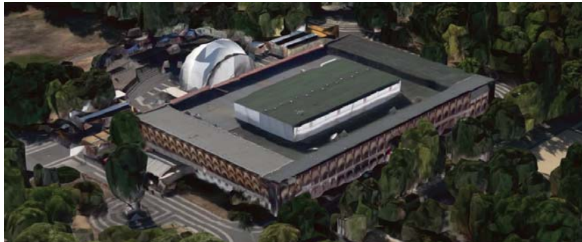
02, Das Gebäude zur Zeit, vor dem Abbruch
