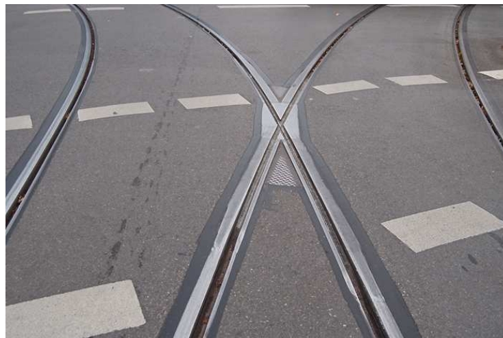
Abbildung 2.6.: Foto eines Flachrillenherzstücks aus dem Straßenbahnnetz München [34].
