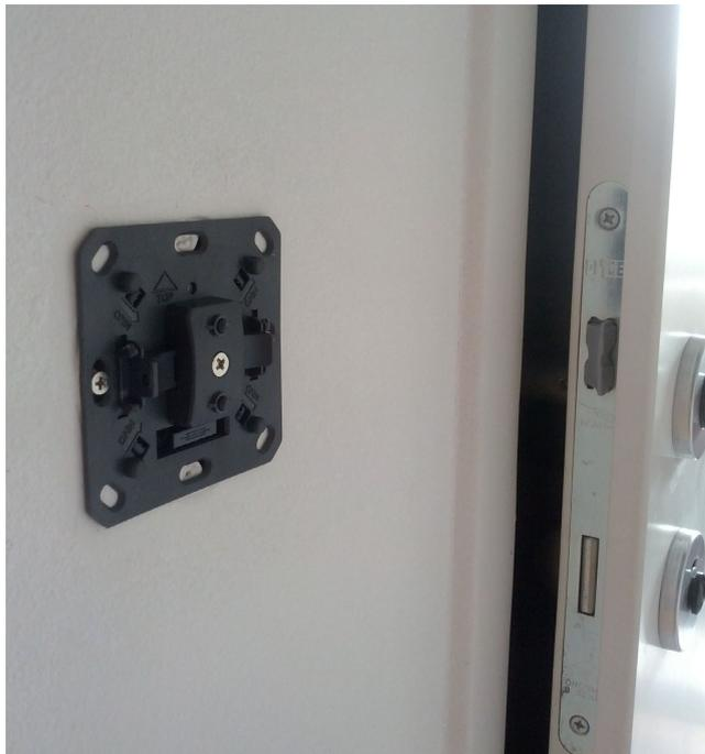
Abbildung 4.5: Montierter Taster ohne Rahmen und Wippe
