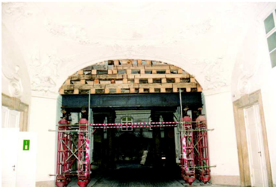
Abbildung 5.16: Ansicht Gewölbe in Hofdurchfahrt [34]
