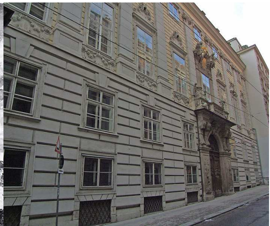
Abbildung 5.15: Aktuelles Bild des Gebäudes [38]
