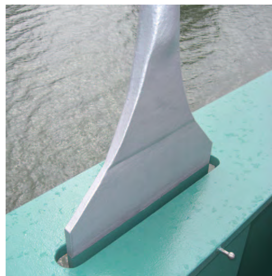
(b) Geschmiedeter Hängeranschluss
