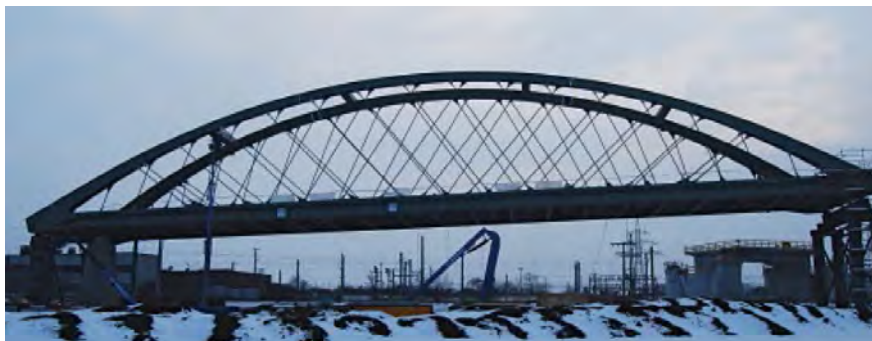
Abbildung 1.1: Netzwerkbogenbrücke beim Verschiebebahnhof Kledering [11]
