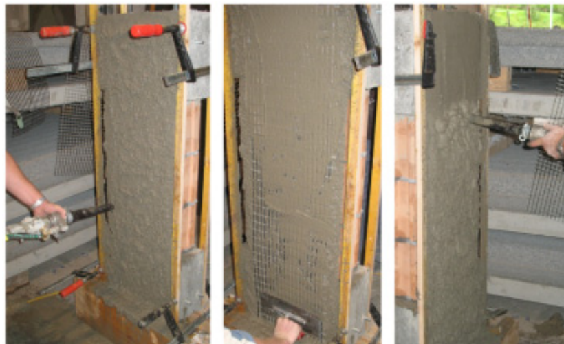
Abbildung 53 – Aufbringen von textilbewehrtem Spritzbeton [53]
