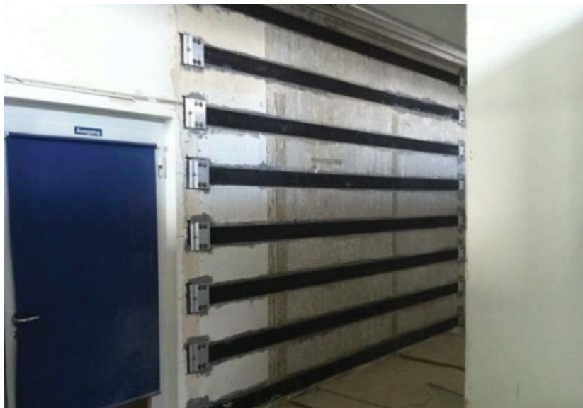
Abbildung 50 – Verstärkung von Wänden mit Stahllamellen, stahlton-bautechnik.ch
