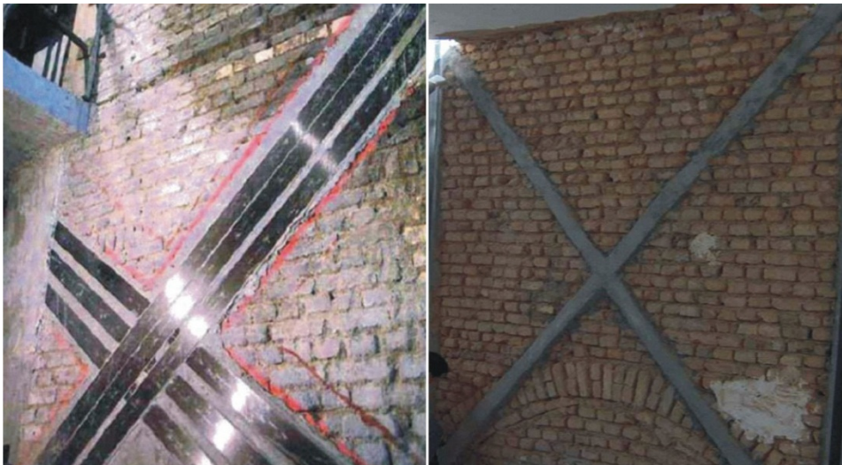
Abbildung 52 – Verstärkung von Mauerwerk mittels Carbonlamellen, Master Builders Australia
