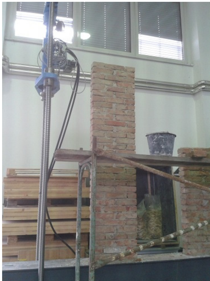
Abbildung 91 – Wandpfeiler 15 x 60 cm während Aufmauerung, Prantl 2014
