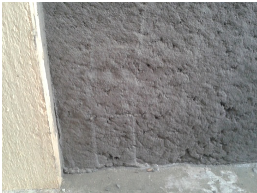
Abbildung 60 – SHCC Schicht, 2 cm dick, mit Zahnschachtel aufgetragen, anschließend geglättet, Prantl 2014
