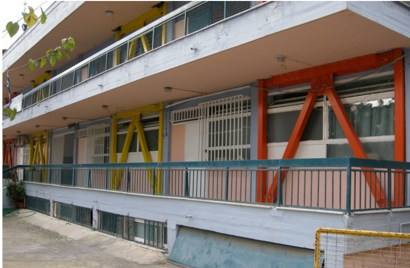
Abbildung 49 – Verstärkung eines Stahlbetongebäudes mit Stahlrahmen, www.pournatzis.com
