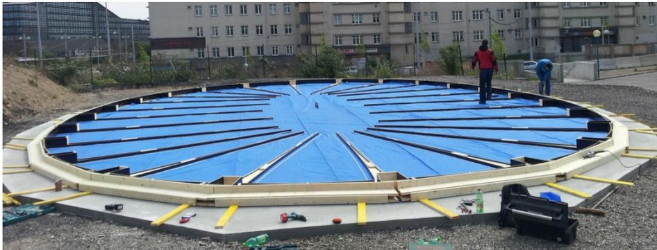
**Abbildung 3.13: Schalung Großversuch**
