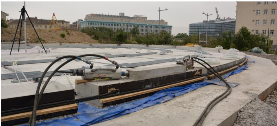
**Abbildung 3.19: Spannpressen und Spannglieder**
