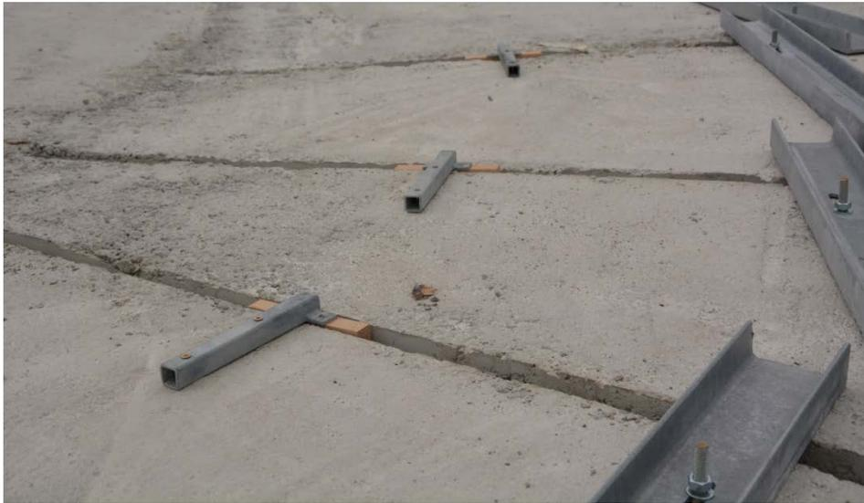
**Abbildung 3.18: Eingebaute Querverschubsicherung und Abstandhalter**
