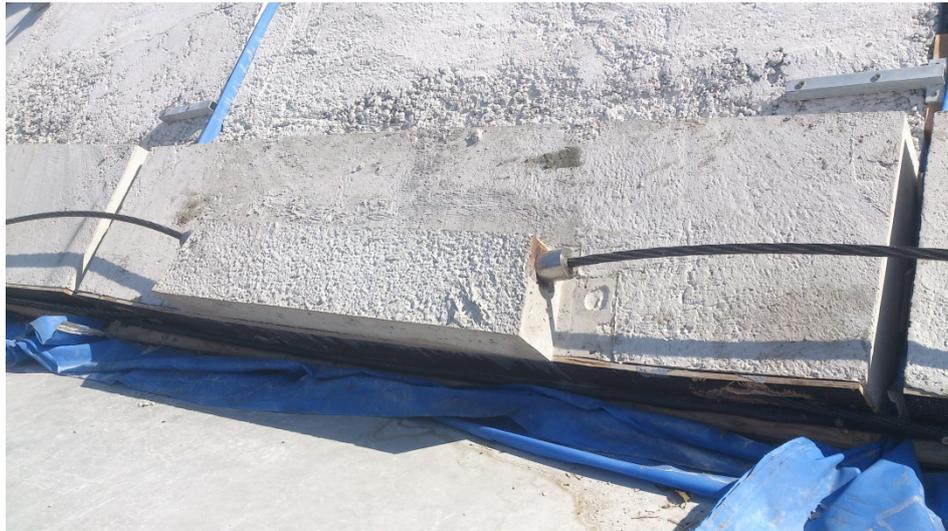
**Abbildung 3.29: Verkeilte Spannglieder in Endposition**
