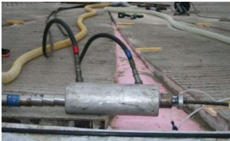
Abbildung 1.27: Hydraulischer Vorspannzylinder
