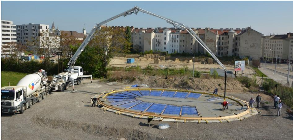
**Abbildung 3.15: Betonage Großversuch**
