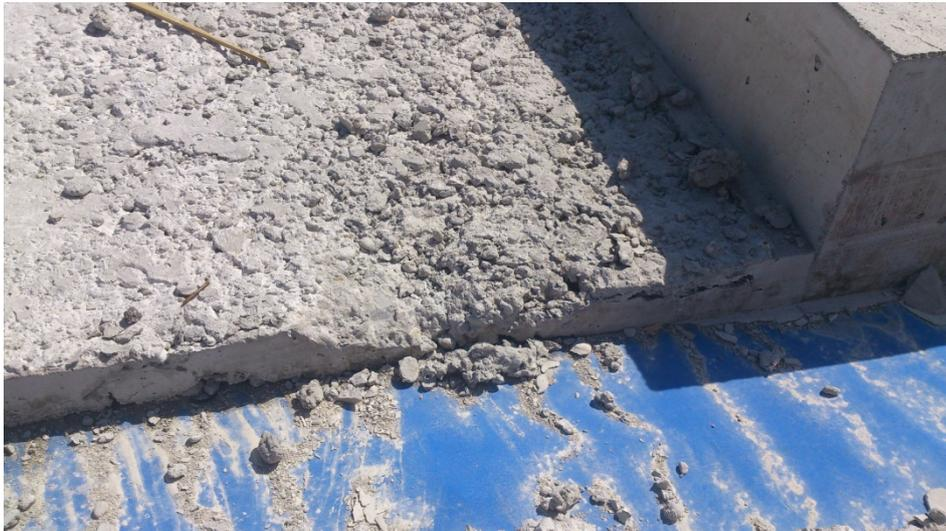
**Abbildung 3.17: Fehlstelle im Beton**
