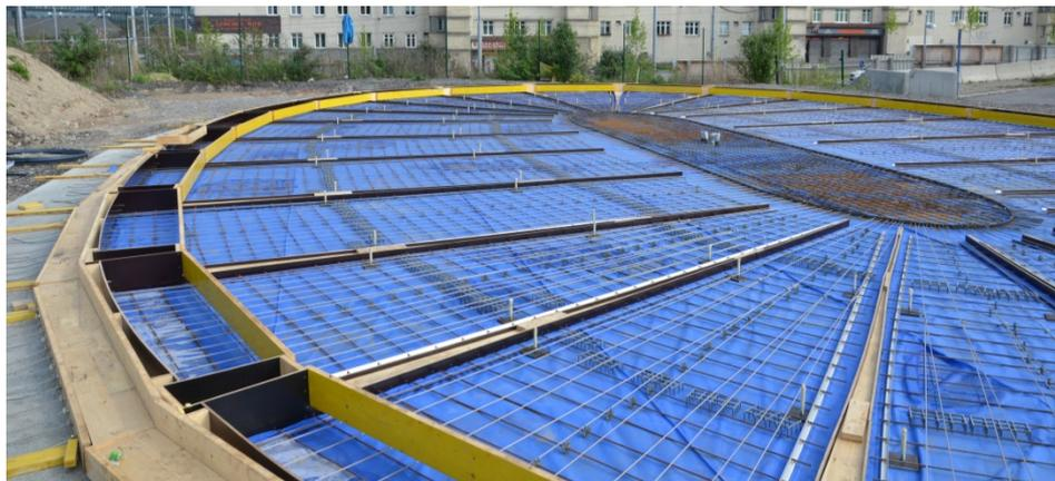
**Abbildung 3.14: Fertig verlegte Bewehrung**
