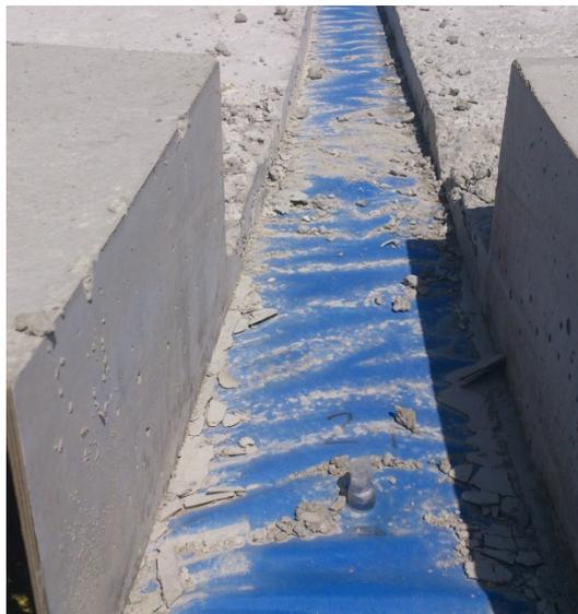
**Abbildung 3.16: Ausgeschaltete Betonplatte**
