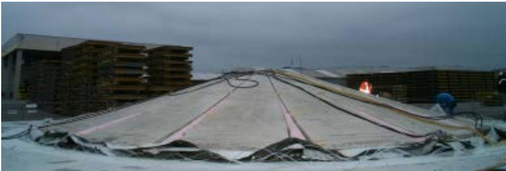
Abbildung 1.26: Betonschale im Umformungsprozess
