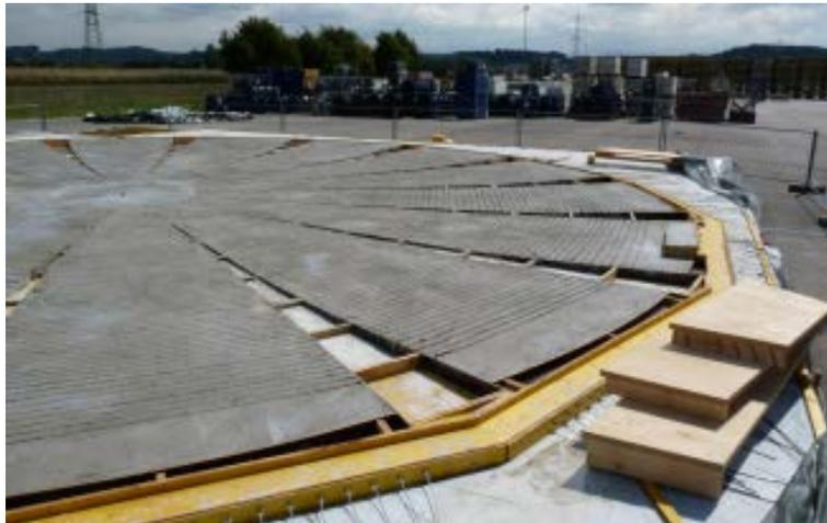
Abbildung 1.22: Betonplatte nach Betonage
