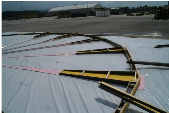
Abbildung 1.18: Auflage keilförmiger Pneus und Abschalelemente
