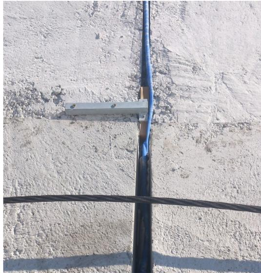
**Abbildung 3.36: Fugenschluss der Schale**
