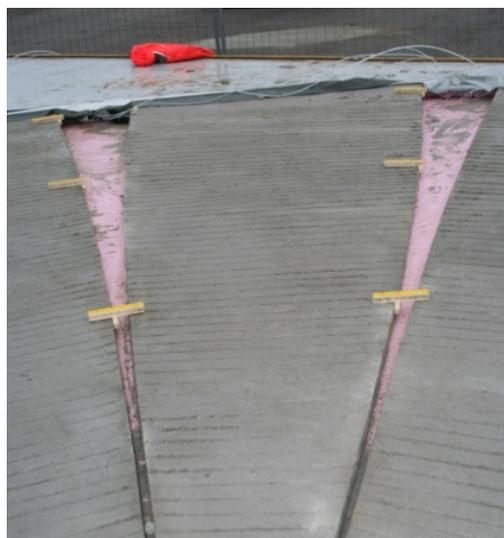
Abbildung 1.23: Betonsegment mit Abstandhalter
