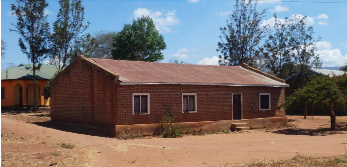
Abbildung 11: Haus aus Ziegelmauerwerk mit Blechdach (Foto: Autorin)
