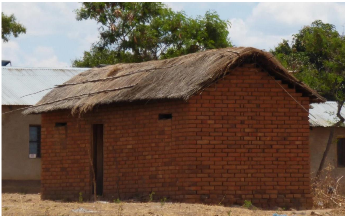
Abbildung 10: Haus aus Ziegelmauerwerk mit Strohdach (Foto: Autorin)
