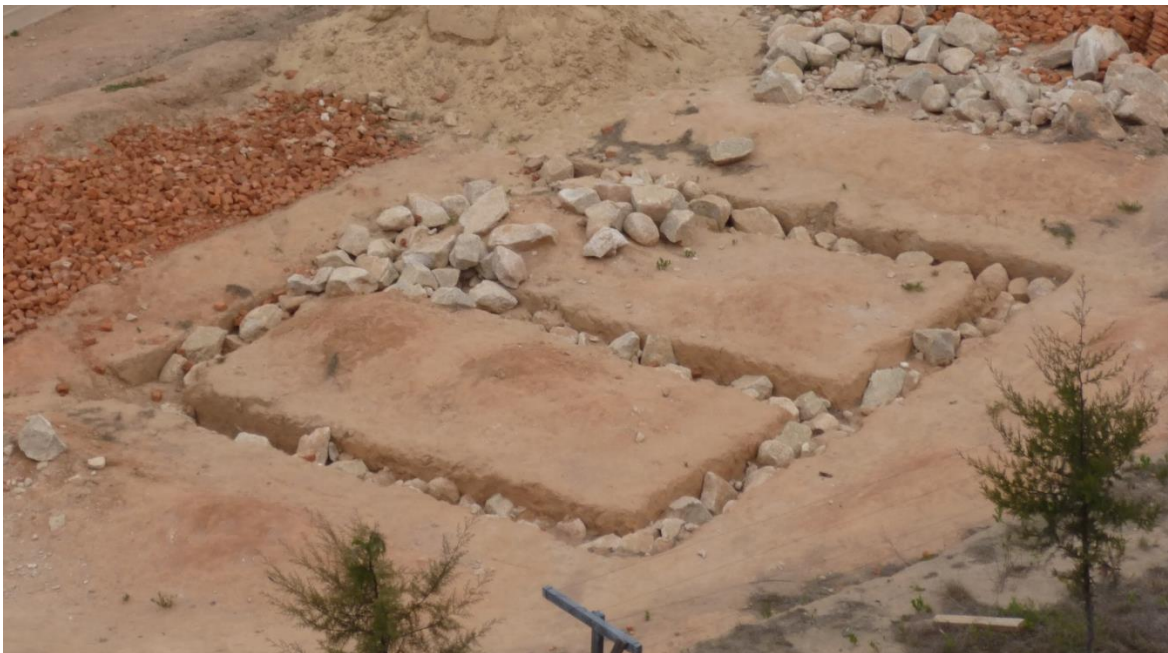
Abbildung 13: Fundament (Foto: Autorin)
