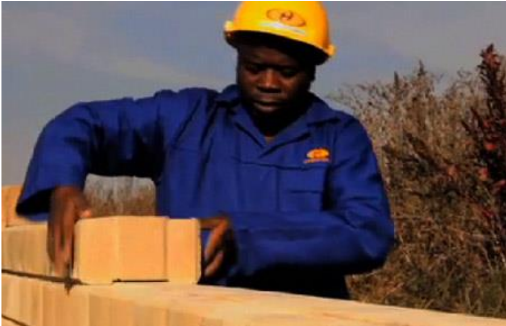
Abbildung 18: Arbeiter verbaut Hydraform [22]
