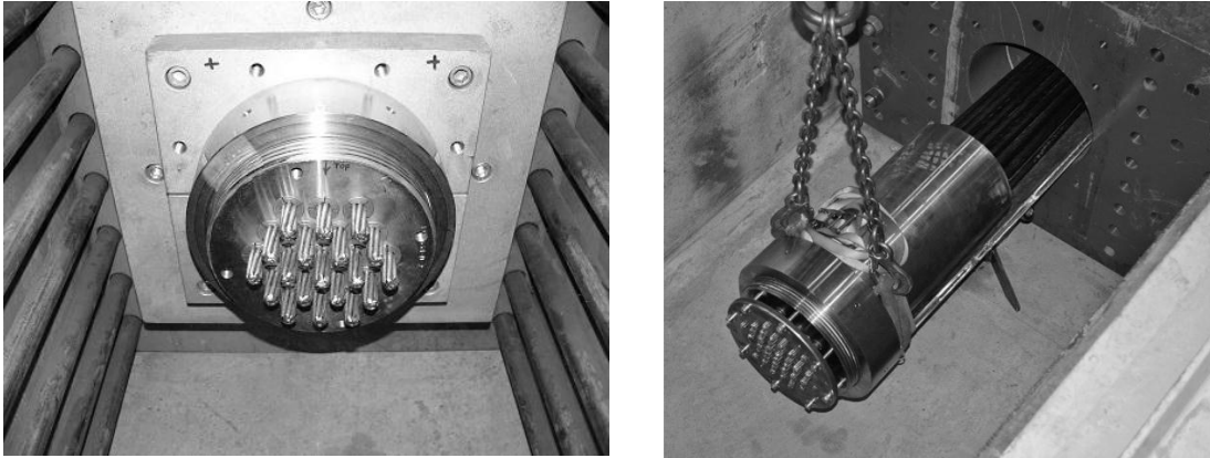
Abb. 34: Schrägkabelverankerungen
