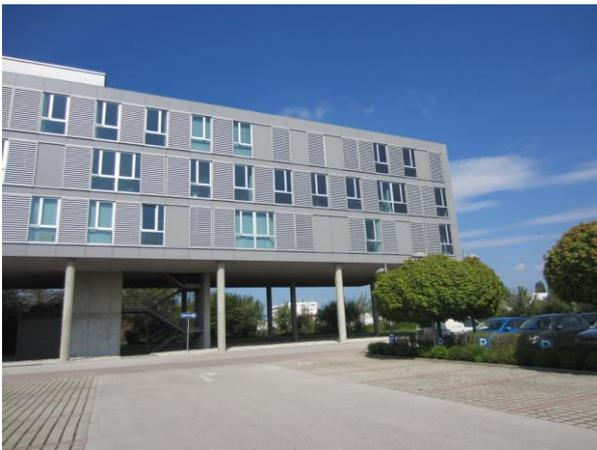
Abbildung 84 - Hauptgebäude - Stahlskelettbau (Quelle: eigenes Foto)
