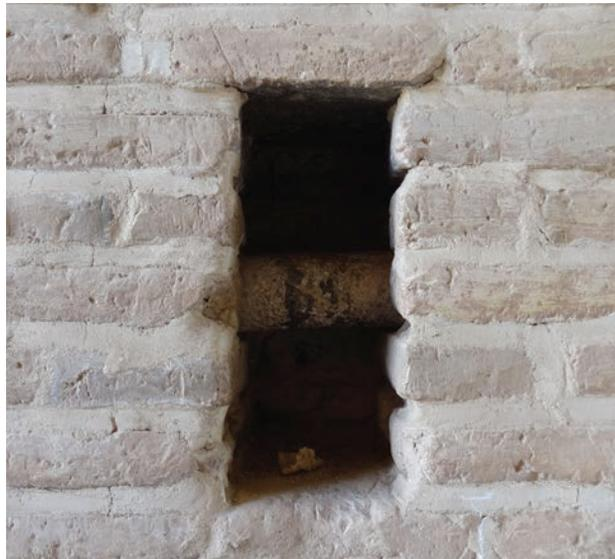
In der *Karawanserei* angelangt, konnten die Karawantiere zum Be- und Entladen an unzähligen dafür vorgesehenen Vorrichtungen, die in den Hofwänden ausgespart waren, angebunden werden, bevor sie anschließend in die Stallungen geführt wurden.<sup>268</sup>
