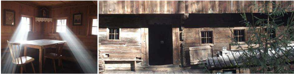
Abbildung 281: Innenansicht der Rahmenstockfenster im Wohnstubenbereich
