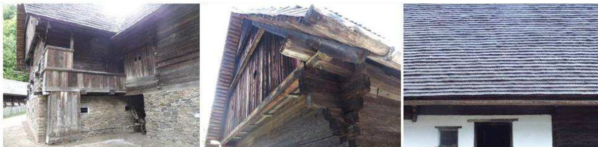
Abbildung 496: Gemauertes Untergeschoß und darüber liegender Holzblockbau im Verschneidungsbereich von Haupthaus und Wiederkehr
