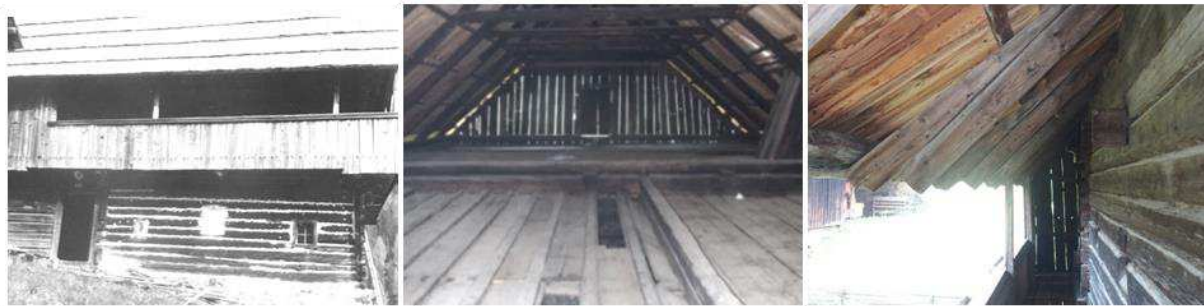
Abbildung 335: Außenwandkonstruktion mit mörtelverputzten Zwischenfugen (Archiv ÖFLM Stübing, 1968)
