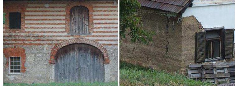
Abbildung 156: Teilverputzte Stampflehmwand in südburgenländischen Neustift bei Güssing (2015)
