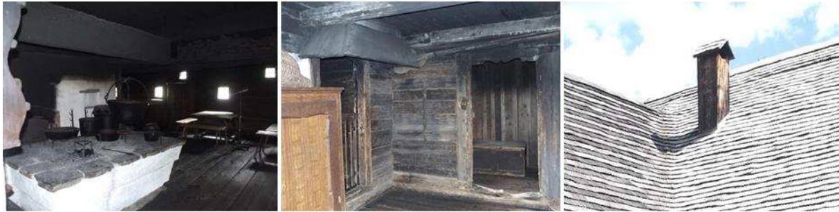
Abbildung 511: Offene Herdstelle der Rauchstubenfeuerstätte Abbildung 512: Rauchhut über dem Eingangsbereich in die Rauchstube Abbildung 513: Rauchableitung über einen hölzernen Rauchschlot
