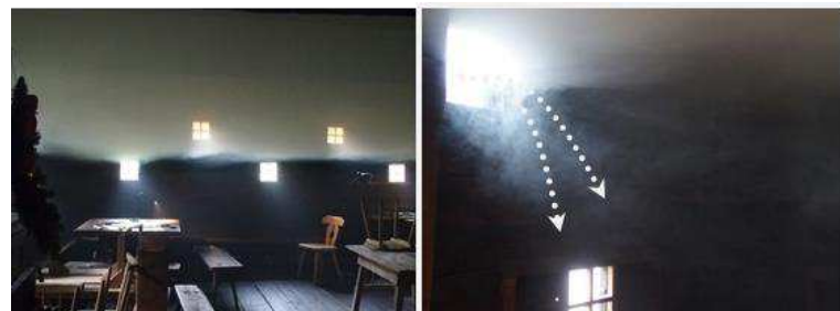
Abbildung 133: Innenansicht der Fensterwand einer (beheizten) Rauchstube mit höhengestaffelten Fenstern, Freilichtmuseum Stübing
