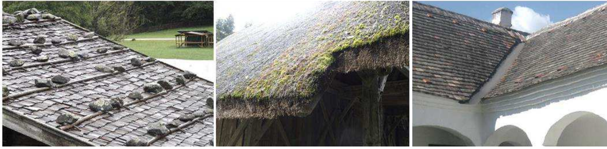
Abbildung 164: Legschindeldeckung mit Schwerstangen, Museum Tiroler Bauernhöfe
