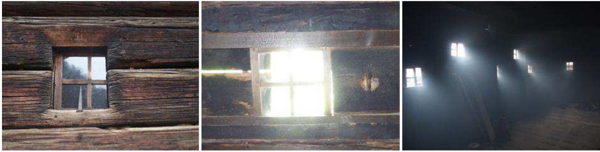
Abbildung 376: Blockbaufenster mit Leibungsabschrägung im Außenbereich
