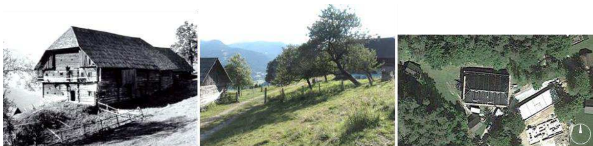
Abbildung 361: Nordostansicht des Gebäudes am Originalstandort (Pöttler, 2001 S. 6)
