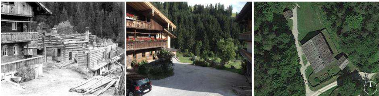
Abbildung 266: Abbau des Hanslerhofes, Ansicht des Scheunenbereichs (Pöttler, 1992a, S. 30)
