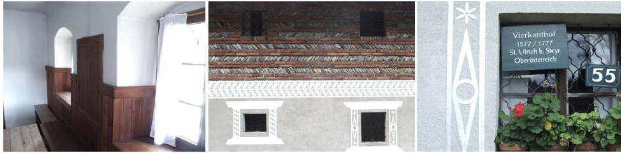
Abbildung 440: Fensterinnenansicht mit trichterförmig ausgebildeter Leibung
