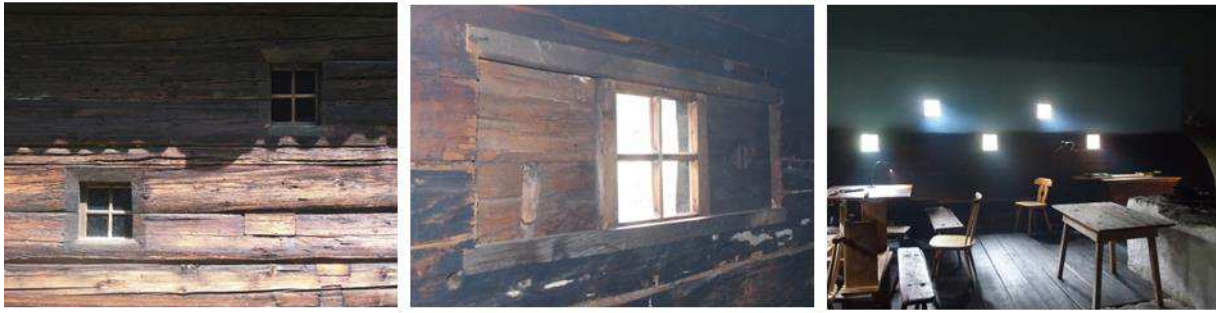
Abbildung 408: Außenansicht der höhengestaffelten Blockbaufenster
