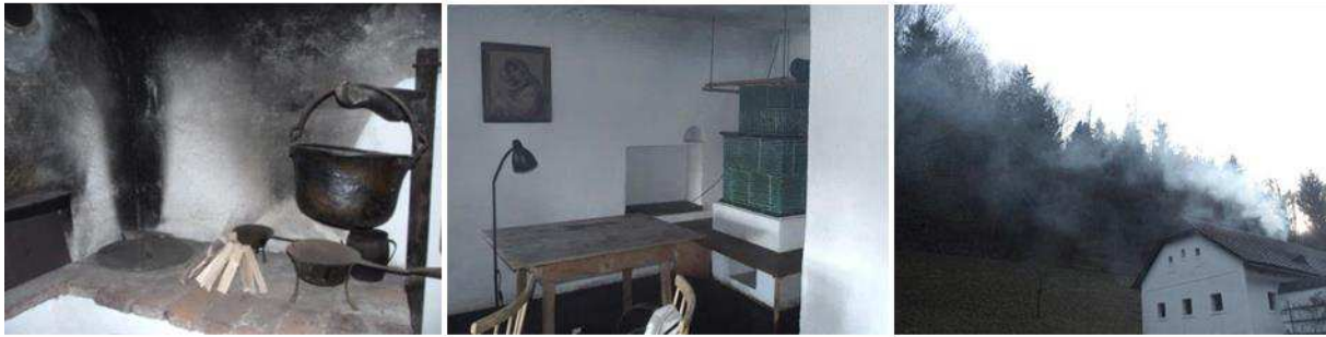
Abbildung 479: Feuerstätte mit offenem Herd und Heizloch für den Stubenofen
