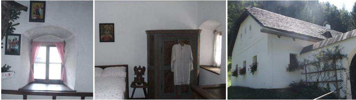
Abbildung 471: Stubenfenster-Innenansicht mit trichterförmiger Leibung
