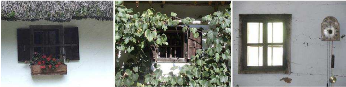
Abbildung 535: Fenster mit vorgelagerten Läden unterhalb der auskragenden Strohdachtraufe
