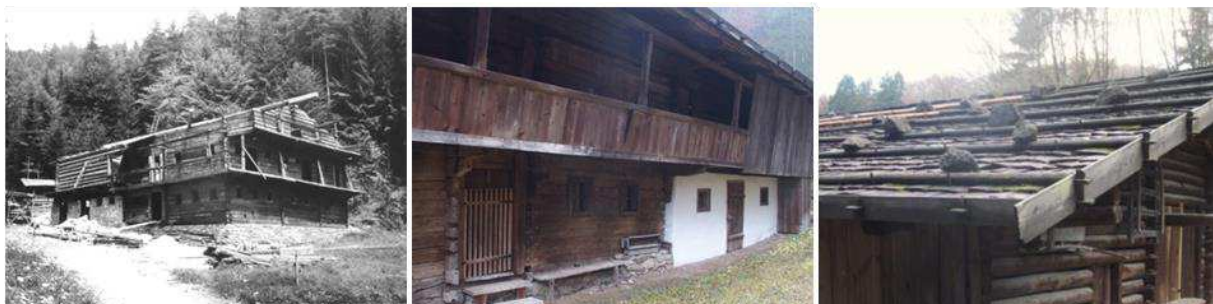
Abbildung 274: Wiedererrichtung des Hanslerhofes auf dem Museumsgelände (Archiv ÖFLM Stübing, 1968) Abbildung 275: Seitenansicht des gezimmerten Wohntraktes und des gemauerten Stallbereiches Abbildung 276: Detailansicht von Schwerstangen, Dachrand und –traufe
