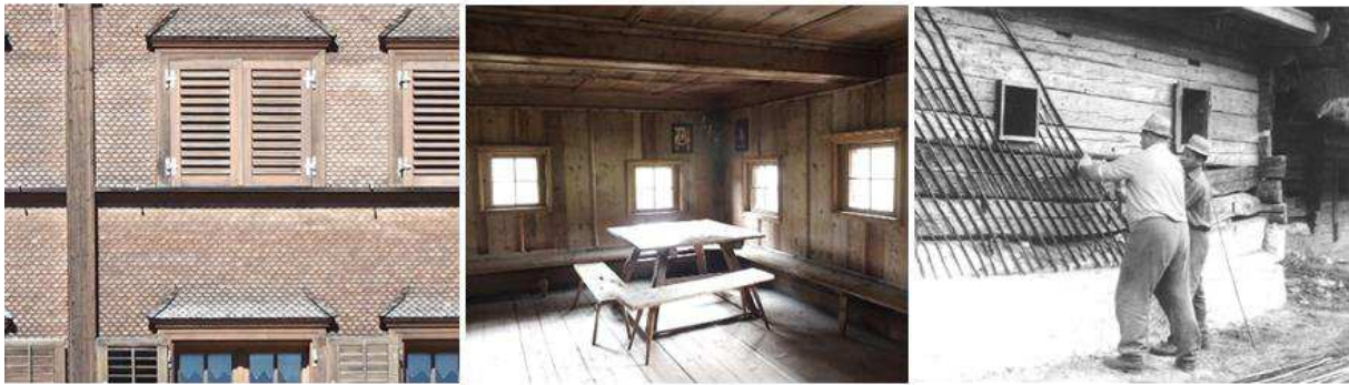
Abbildung 147: Schindelmantel und Klebedächer an einer Hausfassade in Blons, Vorarlberg (2015)
