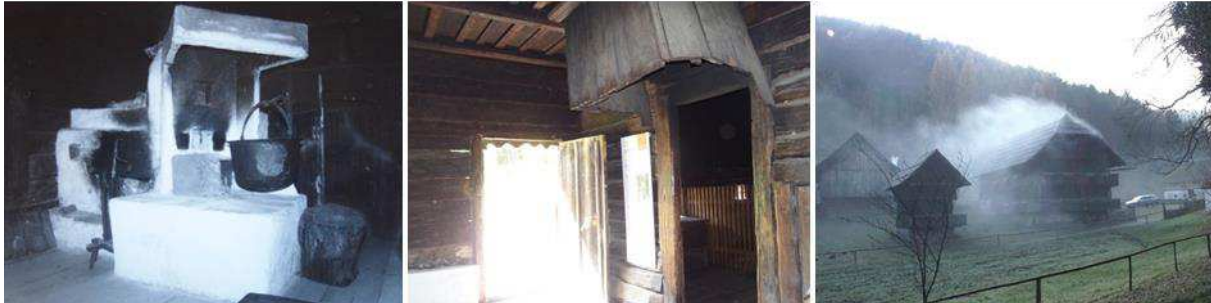
Abbildung 352: Feuerstätte mit diagonal in den Rauchkitchenraum ragendem Funkenhut (Pöttler, 1992b, S. 212)
