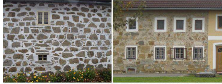
Abbildung 153: Steinbloßmauerwerk in Bad Leonfelden, Mühlviertel (2015)
