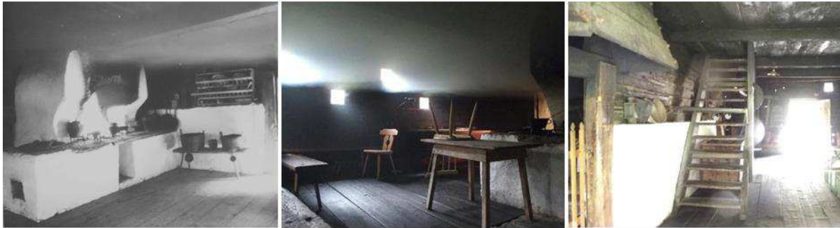
Abbildung 416: Feuerstätte mit gemauertem Funkenhut (Pöttler, 1981a, S. 11)
