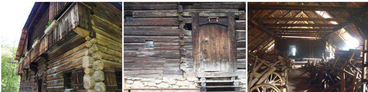
Abbildung 369: Überkämmtete Blockbaukonstruktion mit vorstehenden Balkenenden
