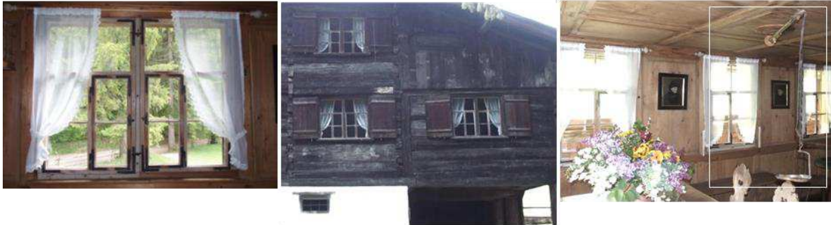
Abbildung 249: Innenansicht eines Stubenfensters mit sechsteiligen Fensterflügeln und integrierten Klappöffnungen
