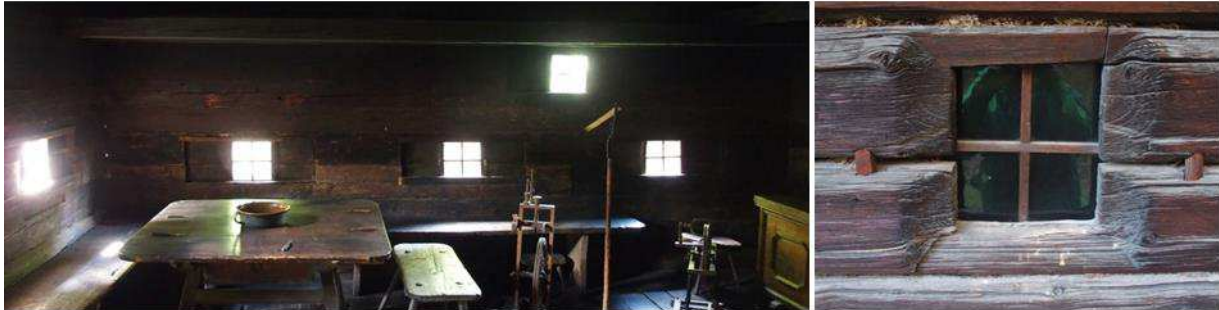
Abbildung 345: Innenansicht der höhengestaffelten Blockbaufenster
