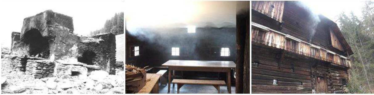
Abbildung 384: Feuerstätte mit gemauertem Funkenhut (Kogel) während des Gebäudeabbaus (Pöttler, 2001, S. 38)
