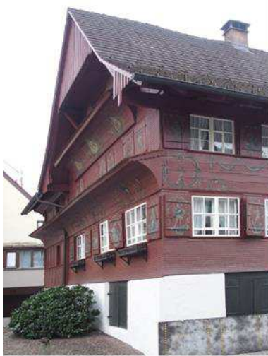
Abbildung 151: Konstruktiver und ornamenthafter Holzschutz einer Fassade in Dornbirn (2015)
