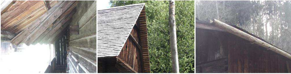
Abbildung 161: Auf Sparren angebrachte Anschüblinge im Dachsaumbereich, Freilichtmuseum Stübing
