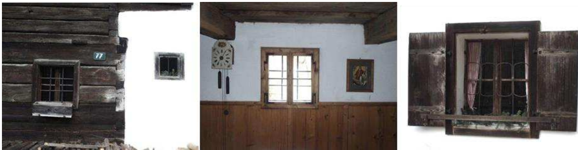
Abbildung 312: Rahmenstockfenster, Außenansicht
