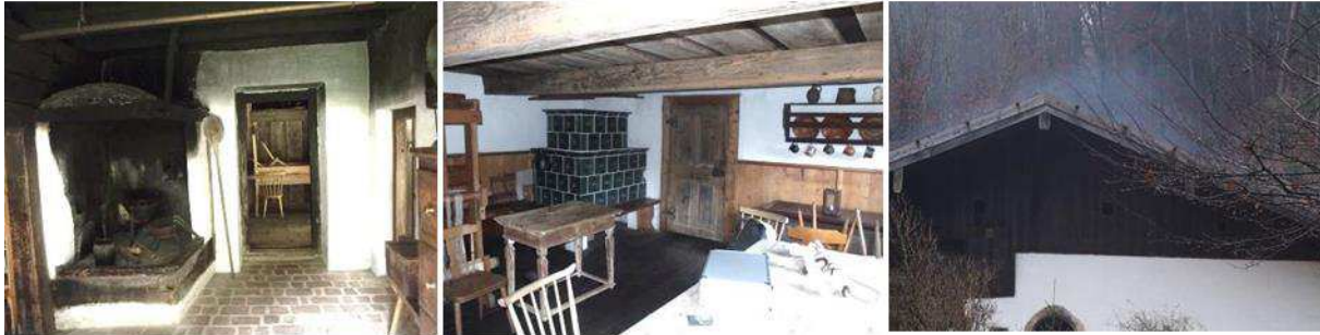
Abbildung 320: Rauchküche mit Küchenherd und abgehängtem Feuerhut
