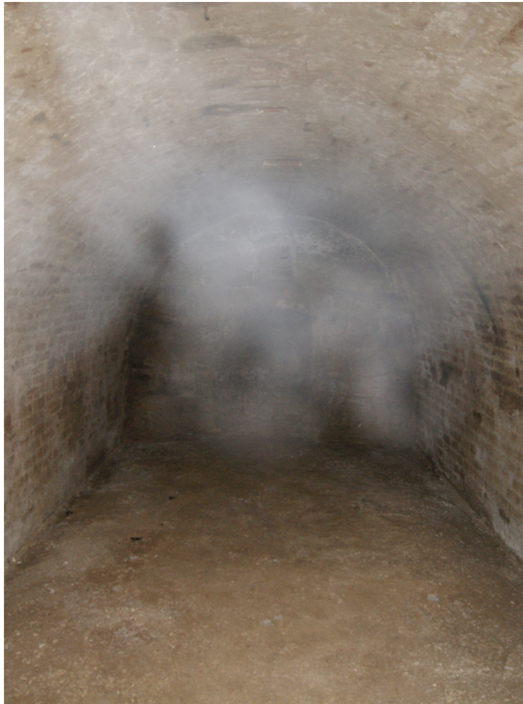
Abb.26: Kellerröhre Bestand mit verschlossener Dampföhre, Foto: Dezember 2018
