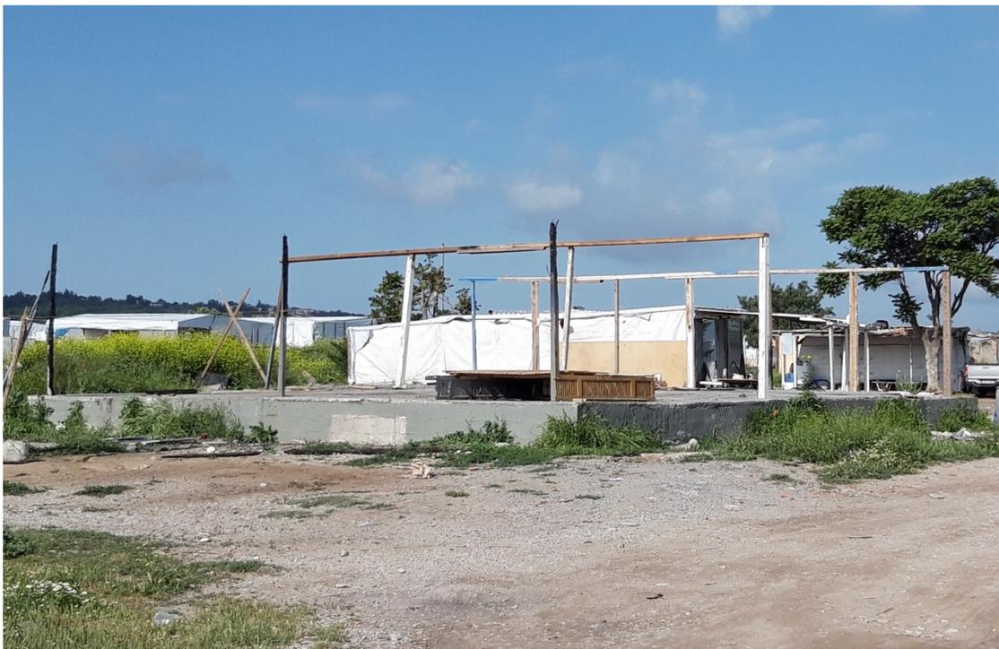
Abbildung 2: Die Betonbasis und das Holzskelett einer Baracke in Peraia, Griechenland.
