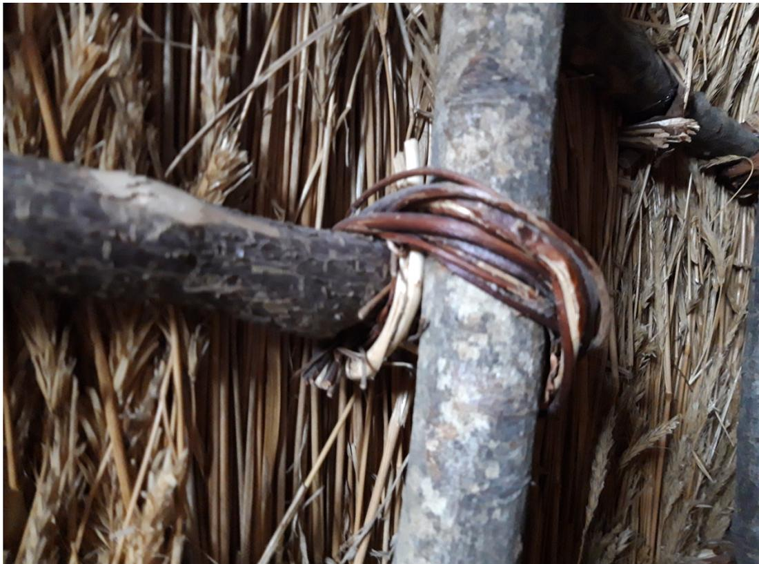
Abbildung 4: Rekonstruktion der kreisförmigen sarakatsanischen Hütte, inneres Konstruktionsdetail, Volkskundemuseum der Sarakatsanen, Serres Griechenland
