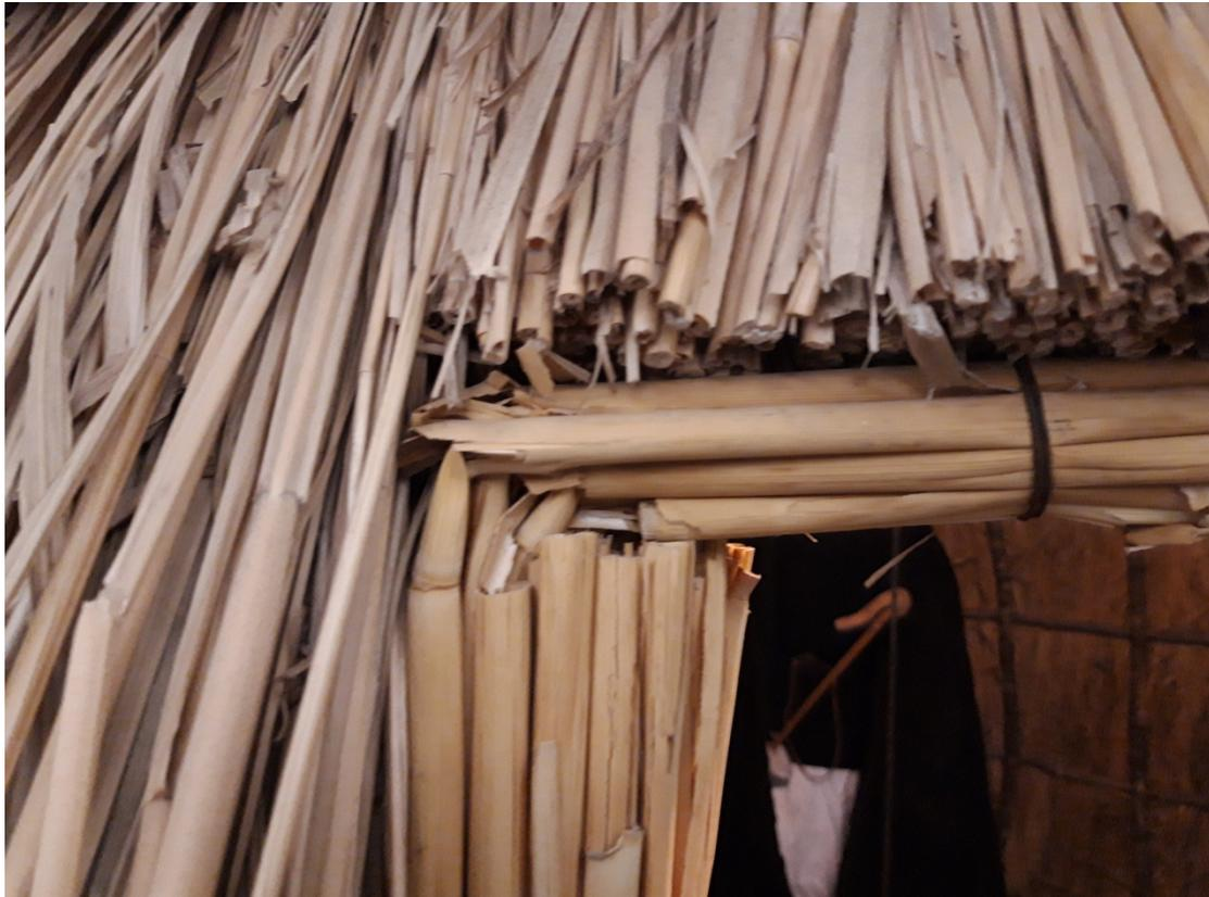
Abbildung 7: *Abbildung 1: Rekonstruktion der kreisförmigen sarakatsanischen Hütte, Türkonstruktionsdetail, Volkskundemuseum der Sarakatsanen, Serres Griechenland*
