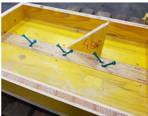
Abb. 43: Anordnung Schrauben 45°/135° und anschließendes Betonieren
