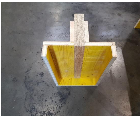
Abb. 39: Zuschnitt LVL und Zusammenbau Schalung
