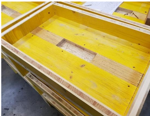
Abb. 46: Anordnung Kerfe mit Kervertiefe 20mm und anschließendes Betonieren
