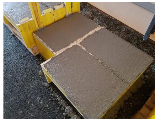
Abb. 41: Anordnung Schrauben unter 45° und anschließendes Betonieren
