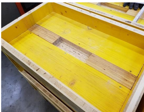
Abb. 48: Anordnung Kerne mit Kervertiefe 30mm und anschließendes Betonieren
