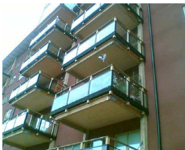
Abbildung 3.45: Ausführungsdetail eines Balkon in Holzbauweise [21]
