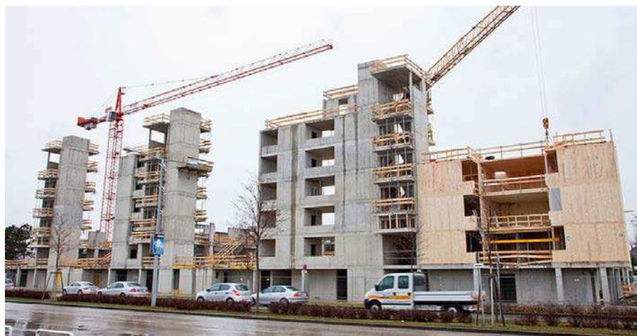
Abbildung 2.29: Vorauseilende Betonbaukerne [64]
