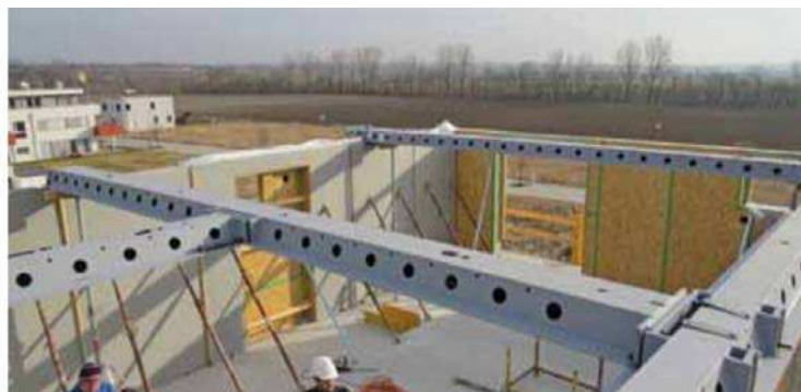
Abbildung 3.15: Auswechselträger aus Stahl mit DeltaBeam® [102]
