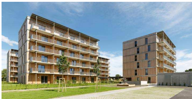
Abbildung 2.3: Holzwohnbau am ehemaligen Gelände der Hummelkaserne in Graz [9]
