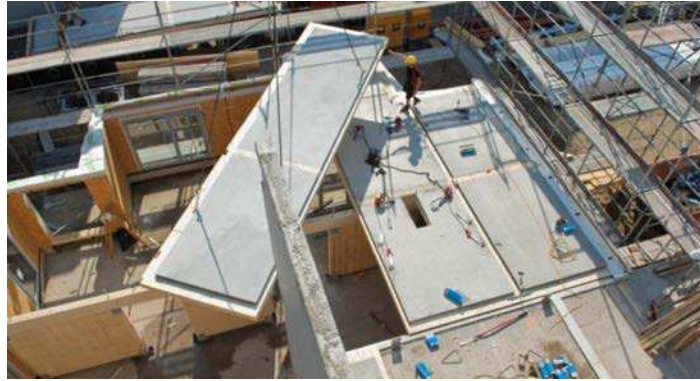
Abbildung 2.24: Versetzarbeiten einer vorgefertigten HBV-Decke [59]
