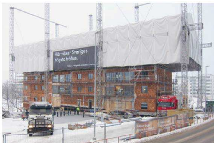
Abbildung 4.1: Witterungsschutz für Konstruktion und Arbeiter durch eine Zeltüberdachung [74]
