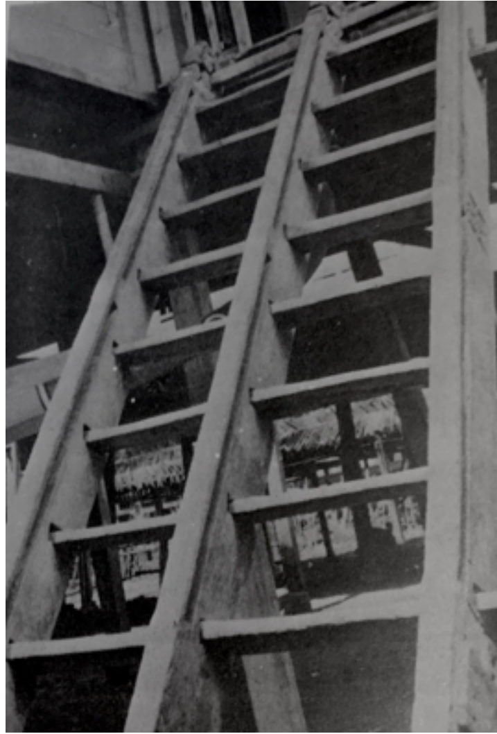
Figure 4.49: Stairs at a noble's house constructed with a parinawang down the center of the staircase (Source: Moh. Yamin Data, M.Arief Mansyur, and Abd.Gani Anta, Bentuk Rumah Bugis Makassar (Proyek Pengembangan Media Kebudayaan Direktorat Jenderal Kebudayaan Departemen Pendidikan dan Kebudayaan RI, 1977)page 50
