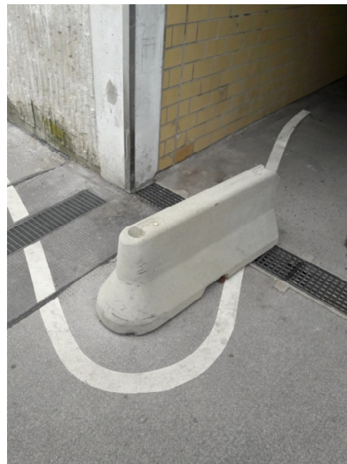
Abb. 98: Engstelle - Unterführung S-Bahn Leopoldau
