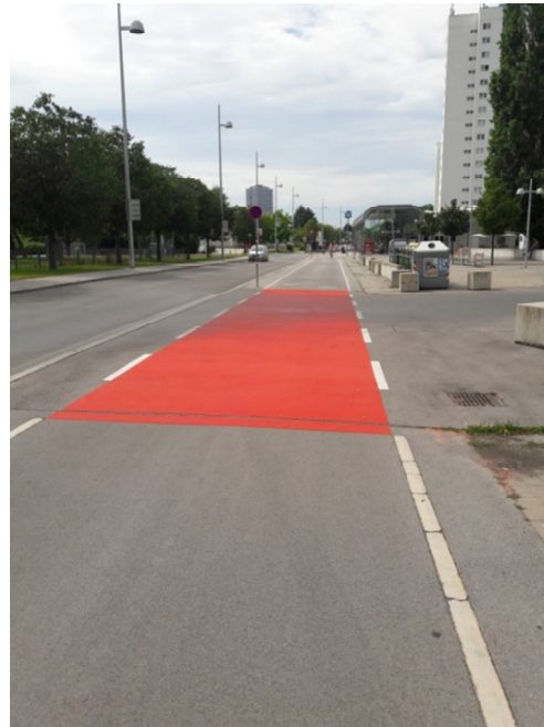
Abb. 94: Einfahrt Einkaufszentrum Großfeldzentrum
