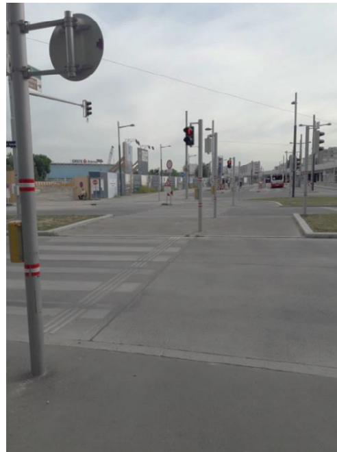
Abb. 84: Straßenüberfahrt U-Bahn Kagran
