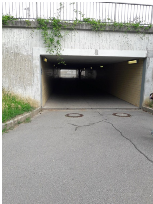
Abb. 97: Unterführung S-Bahn Leopoldau
