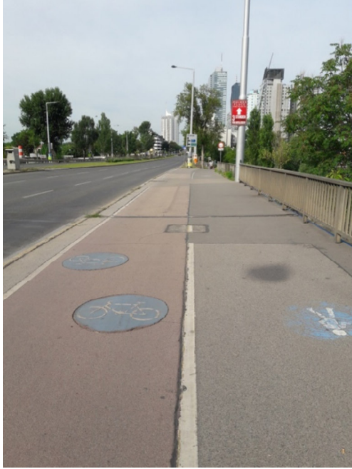
Abb. 79: Zweirichtungsradweg Kagraner Brücke, straßenbegleitend
