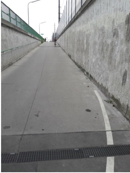
Abb. 99: Rampe Unterführung S-Bahn Leopoldau
