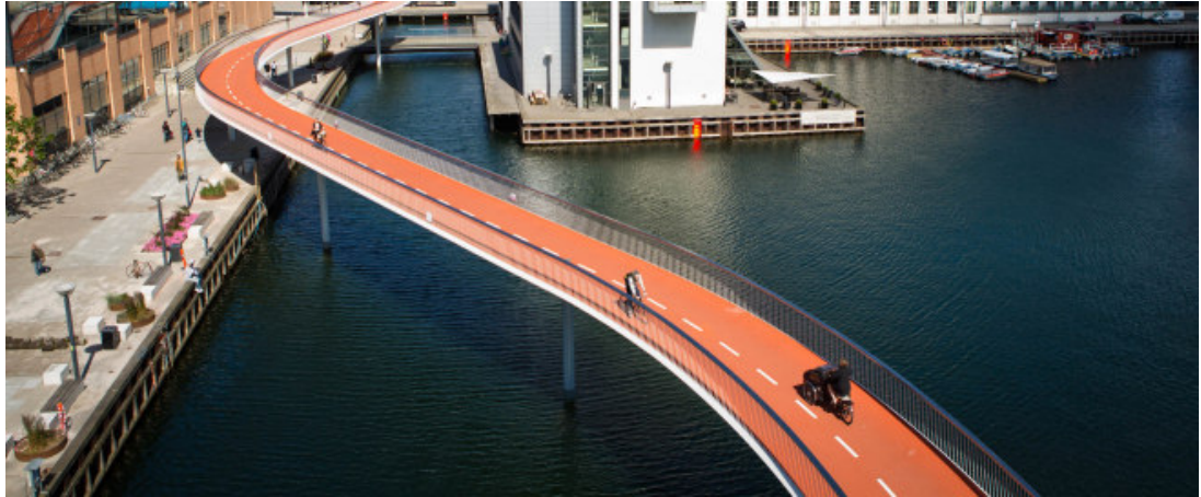
Abb. 27: Zweirichtungsradschnellverbindung – getrennt geführt über eine Brücke
