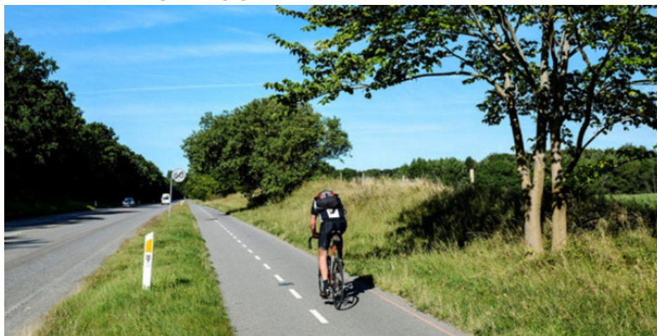
Abb. 31: Zweirichtungsradweg, getrennt vom KFZ-Verkehr
