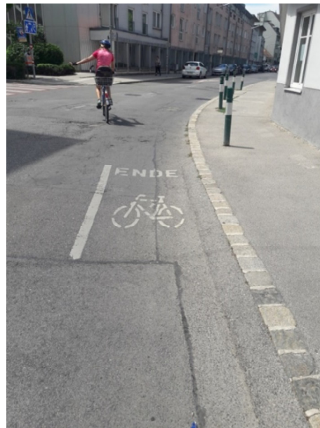
Abb. 122: Mehrzweckstreifen, Hetzendorfer Straße
