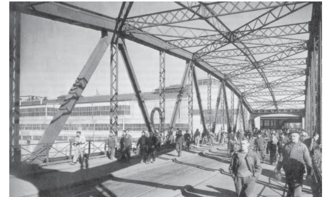
Abb. 14 Schichtwechsel auf der Brücke 1951
