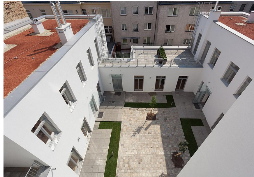
Abb. 14 Gemeinschaftsterrasse Neulerchenfelder Straße 83
