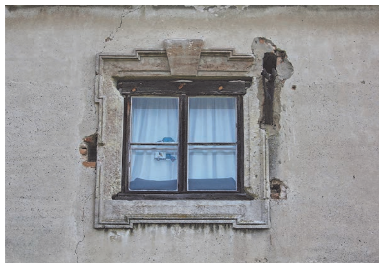
Abbildung 34 Schloss Thürnthal, Fenster im Mezzanin eigene Aufnahme, April 2015
