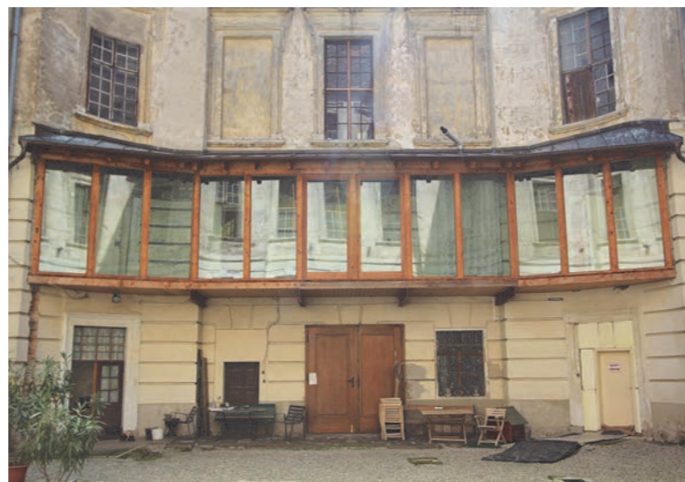
Abbildung 93 Verbindungsgang im Mezzanin eigene Aufnahme, Oktober 2015
