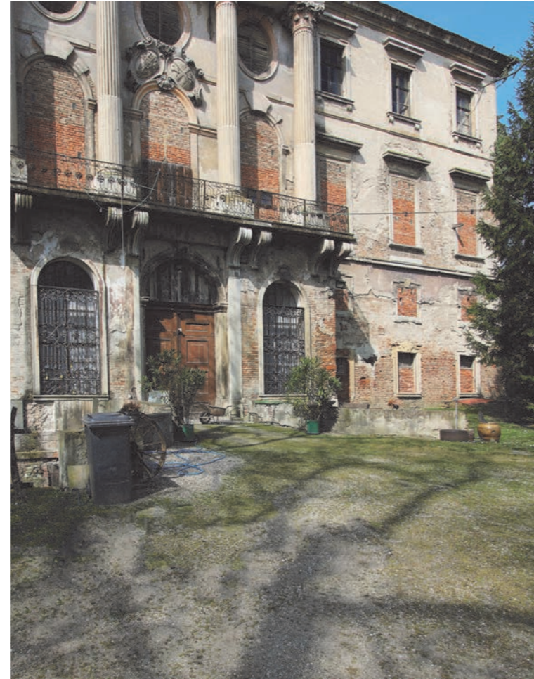
Abbildung 87 Vergleichsfoto: Die Firsthöhe des Anbaus ist an der Fassade noch klar ablesbar. eigene Aufnahme, April 2015
