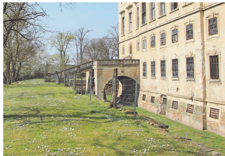
Abbildung 33 Schloss Thürnthal, Althane auf der Höhe des Mezzanins eigene Aufnahme, April 2015
