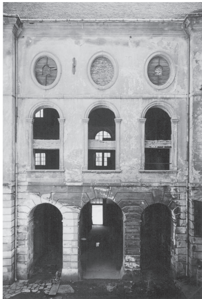
Abbildung 71 Vergleichsfoto: Hoffassade des Osttraktes Aufnahmedatum unbekannt, nach der Demontage der Hofeinbauten (= nach 1908), jedoch vor 1941 Quelle: BDA Wien, Fotoarchiv
