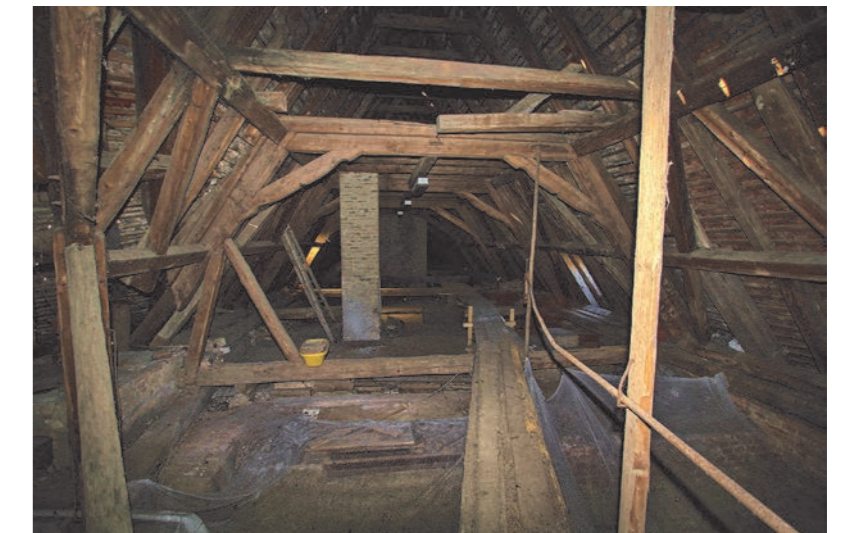
Abbildung 69 Dachstuhl Nordtrakt eigene Aufnahme, April 2015
