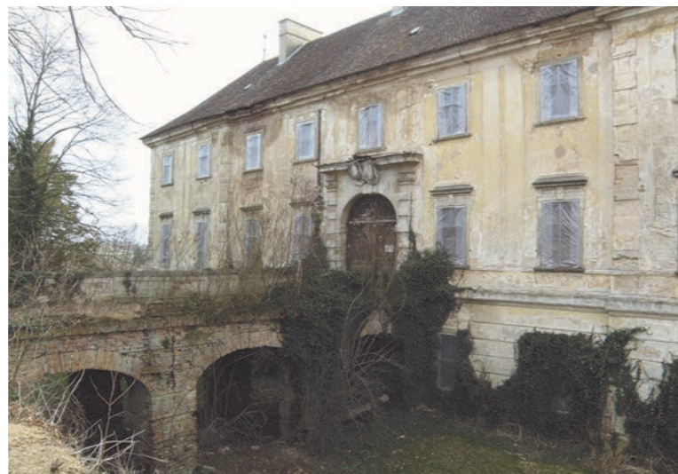
Abbildung 24 Vergleich: Schloss Ladendorf, östlicher Wehrgraben mit Brücke eigene Aufnahme, März 2011
