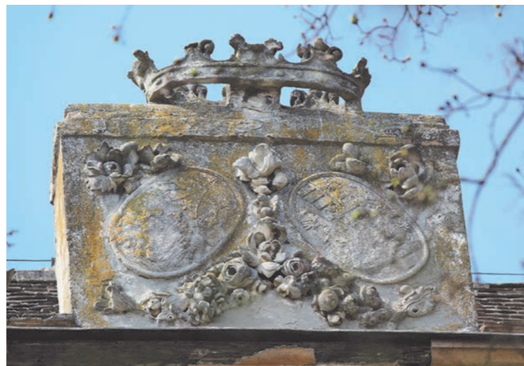
Abbildung 15 Detail: Attika, Wappen, Ostfassade vermutlich das Familienwappen der Familie Stettner eigene Aufnahme, April 2015
