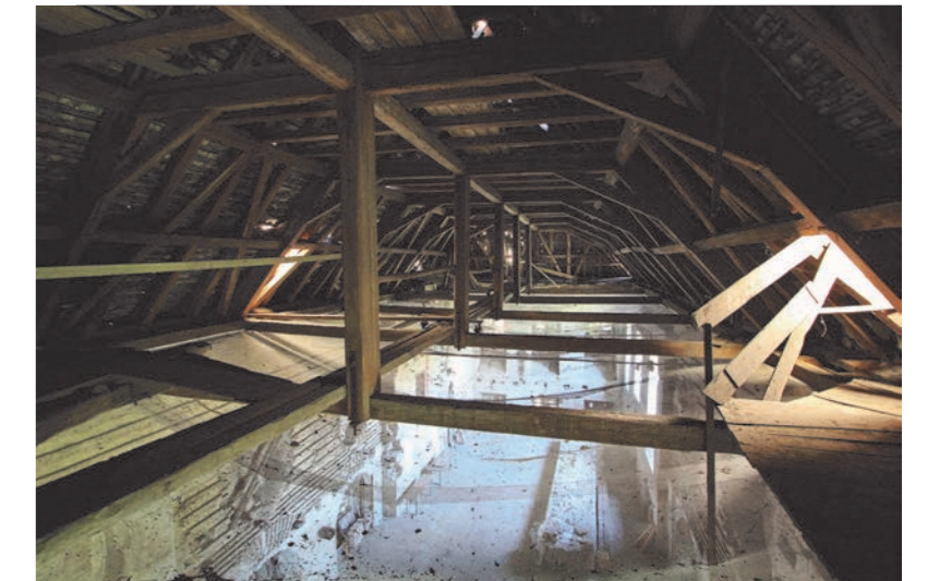
Abbildung 68 Dachstuhl Osttrakt (über dem großen Saal) eigene Aufnahme, April 2015
