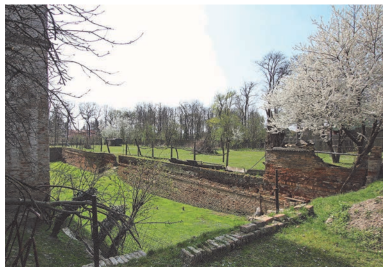
Abbildung 25 Schloss Thürnthal, westlicher Wehrgraben eigene Aufnahme, April 2015
