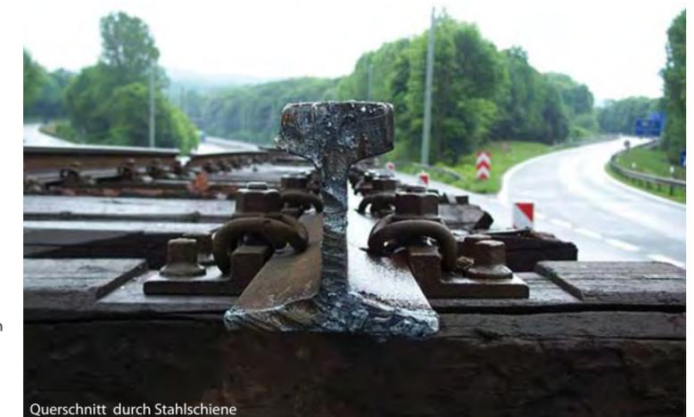
Querschnitt durch Stahlschiene
