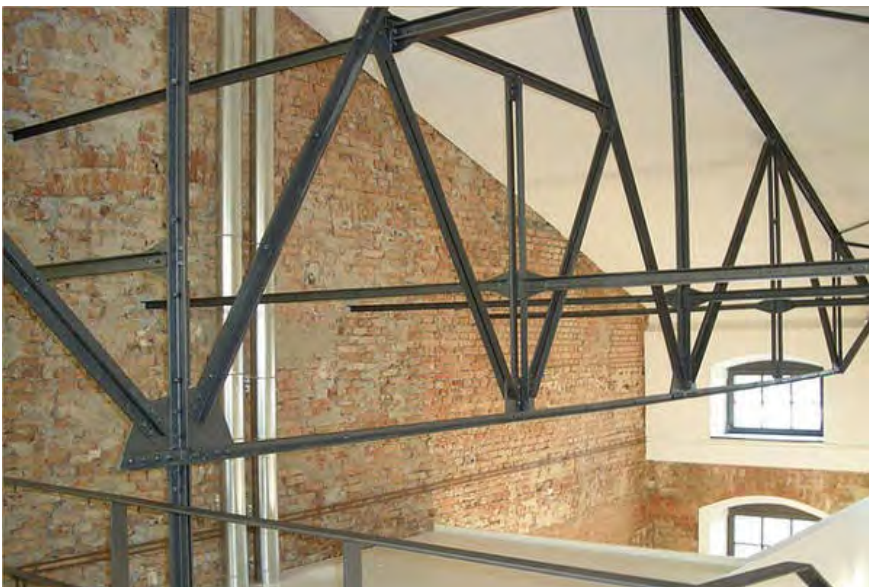
Abbildung 39 - 40 | Leichte Stahlkonstruktion vs Ziegelmauerwerk, reversible Elemente im Bestand, Alte Spinnerei Kolbermoor, Quest Architekten
