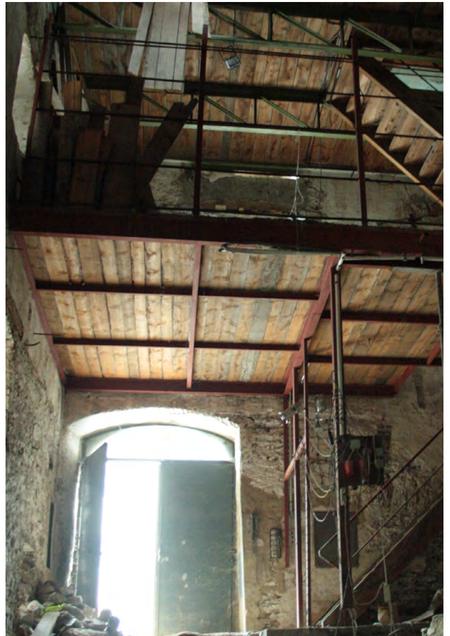
Abbildung 34 | Haupteingang, Erschließung Palasbau Innenansicht
