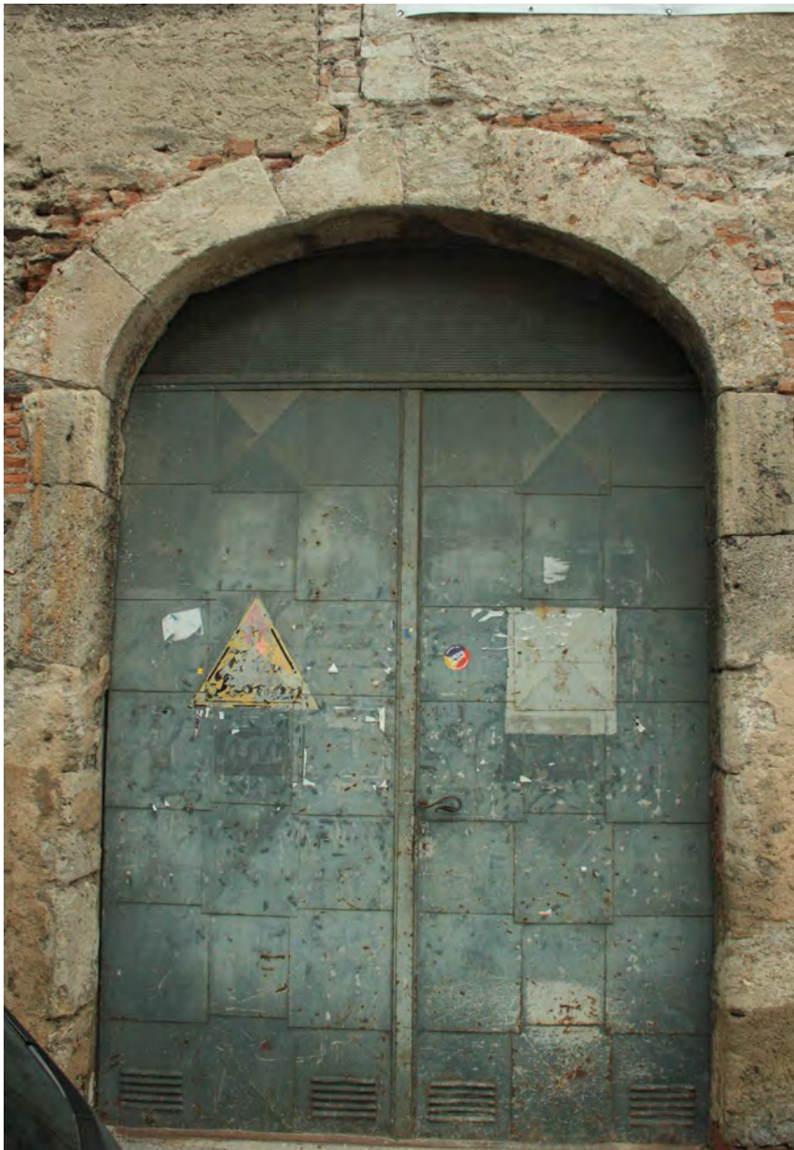
Abbildung 33 | Haupteingang Palasbau Aussenansicht 70
