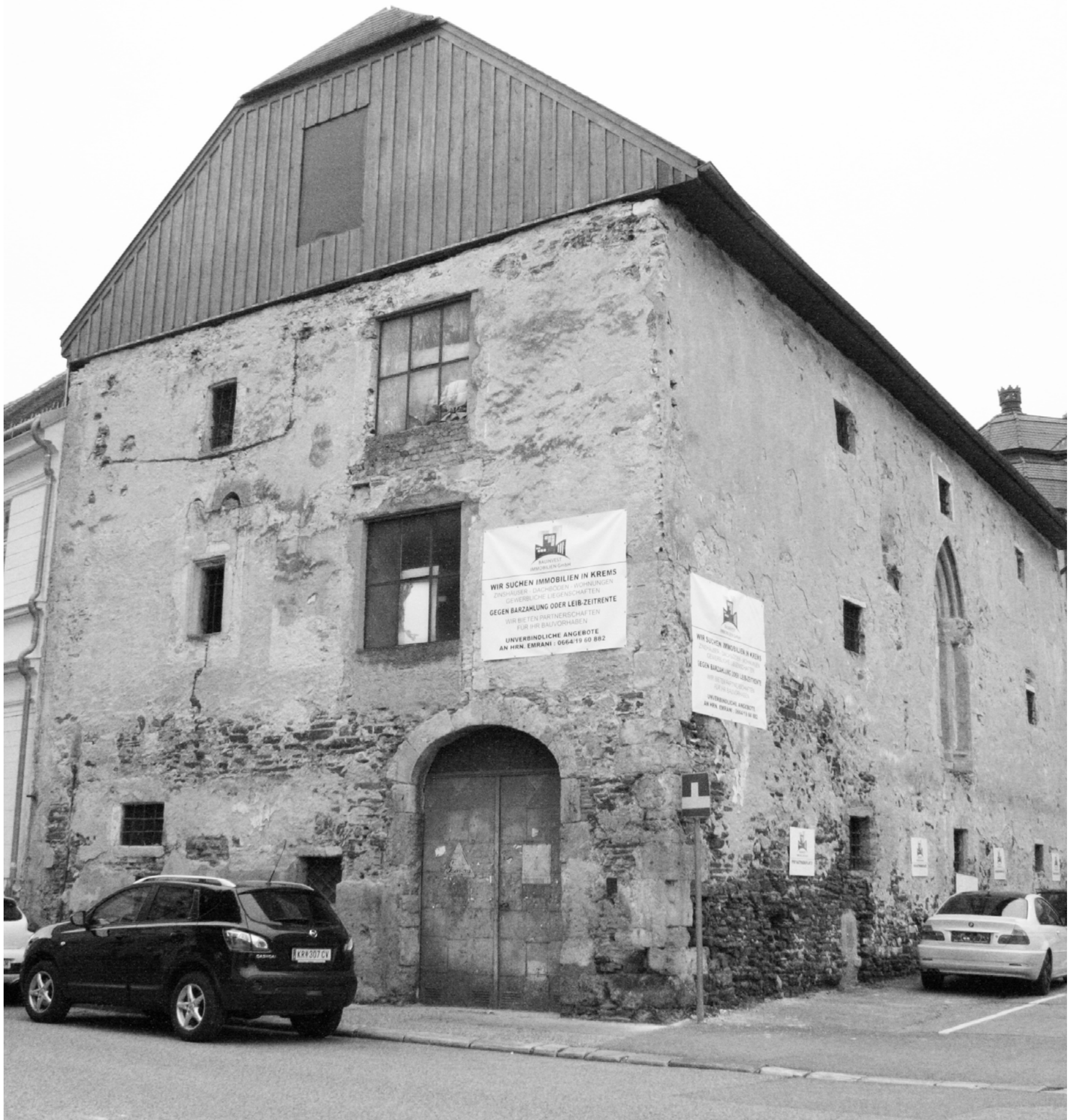
Abbildung 1 | Herzoghof Palasbau, Nord- Westfassade 16
