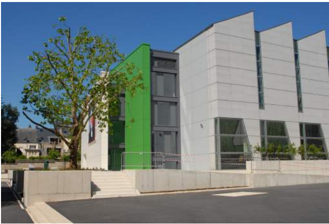
Abb. 176 Neuer Anbau mit Fluchttreppe (2015)
