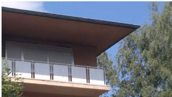
Abb. 206 Weit auskragendes Flachdach am Appartementhaus Hansen
