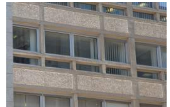
Abb. 217 Centre Louvigny mit vorgehängtem Betonraster und Waschbeton-Platten
