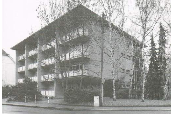
Abb. 43 Hauptfassade mit Loggien
