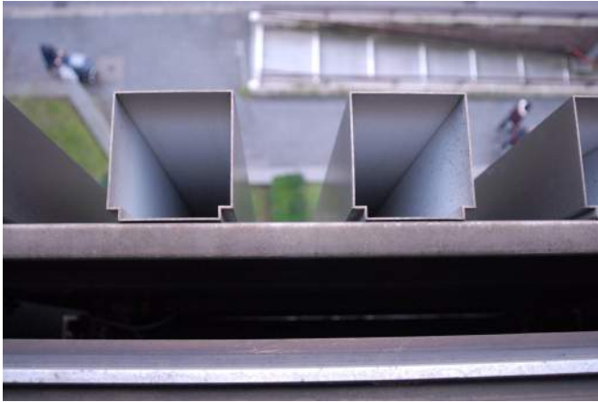
Abb. 213 Detailansicht der Aluminiumfassade an der Banque Général
