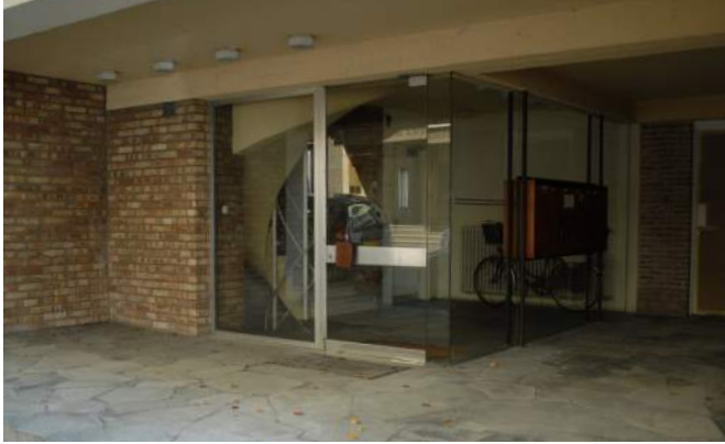
Abb. 62 Eingangsbereich mit integrierter Glashalle (2014)
