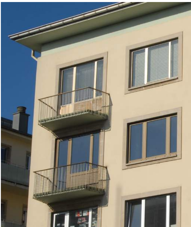
Abb. 55 Detail unterschiedlicher Fensterrahmen (2014)
