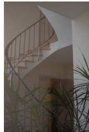
Abb. 239 Schwungvolle Treppe im Appartementhaus Mailliet
