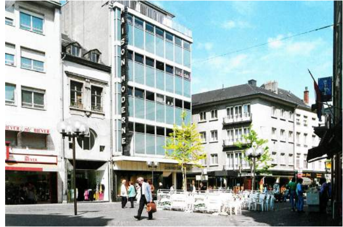
Abb. 20 Geschäftshaus Maison Moderne, 1971 von Robert Lentz (1990)
