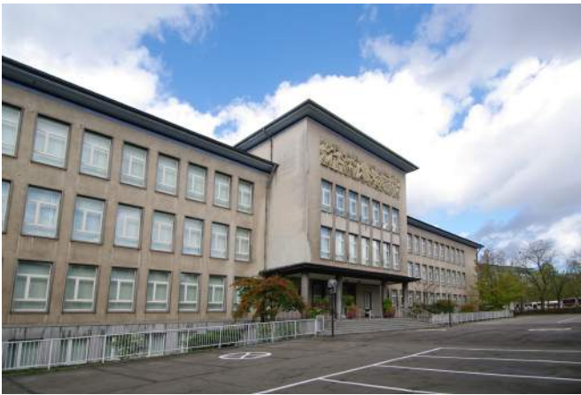
Abb. 154 Hauptfassade mit ausgewechselten Fenstern (2013)
