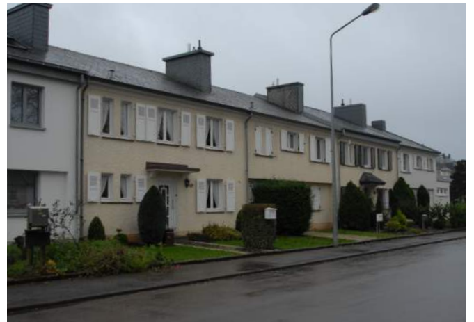
Abb. 77 I. Bauphase, Haustyp Cub in der Rue de la Forêt (2014)
