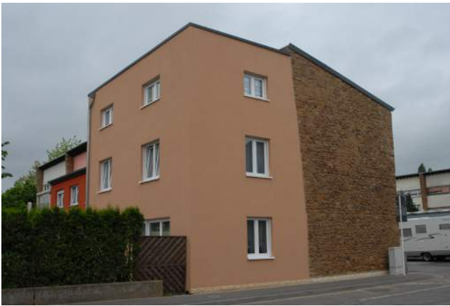
Abb. 85 Vollständiger Verlust der ursprünglichen Südfassade (2015)
