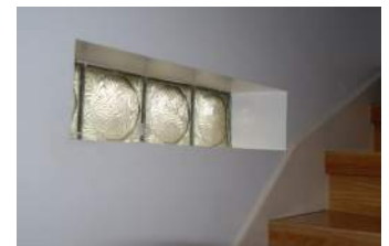
Abb. 231 Glasbausteine im Treppenhaus in der Cité Eugène Reichling
