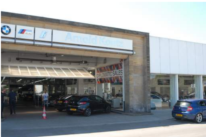
Abb. 107 Massives Eingangsportal in der Rue de Neufchâteau (2015)
