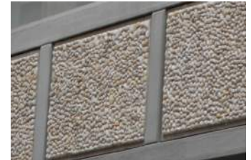
Abb. 263 Raster aus Sichtbeton mit Moselkies-Platten am Centre Louvigny
