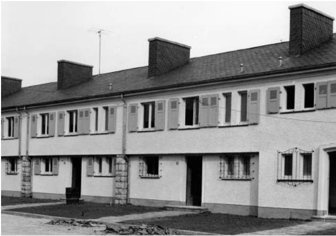
Abb. 74 I. Bauphase, Haustyp Cub in der Rue des Prunelles (um 1958)
