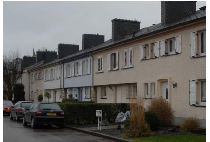
Abb. 75 I. Bauphase, Haustyp Cub in der Rue des Prunelles (2014)
