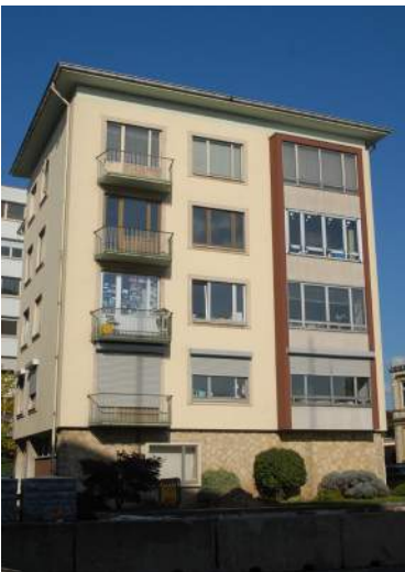
Abb. 57 Südfassade mit Erker (2014)
