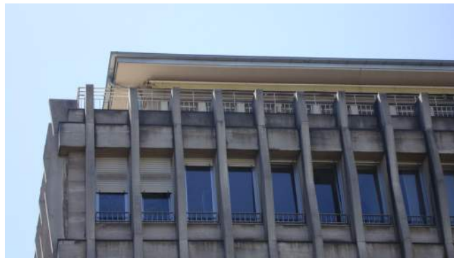
Abb. 207 Dachgeschoß mit Terrasse und Flugdach am Centre Puits-Rouge
