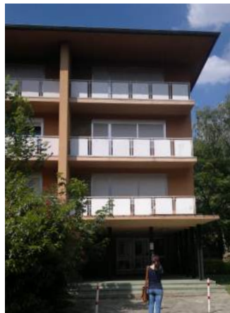
Abb. 238 Loggien mit weißen Brüstungen am Appartementhaus Hansen
