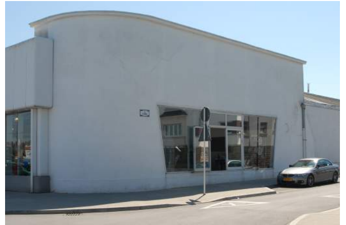
Abb. 109 Westfassade Rue d'Ivoix (2015)
