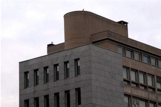
Abb. 121 Dachgeschoß Ecke Rue Monterey / Rue Aldringen (2014)
