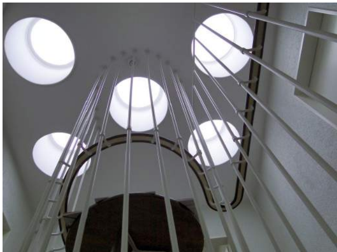
Abb. 41 Treppenhaus mit runden Dachfenstern (2014)
