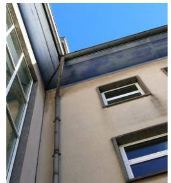
Abb. 212 Weit auskragendes Dach mit blauer Untersicht an der Europäischen Schule
