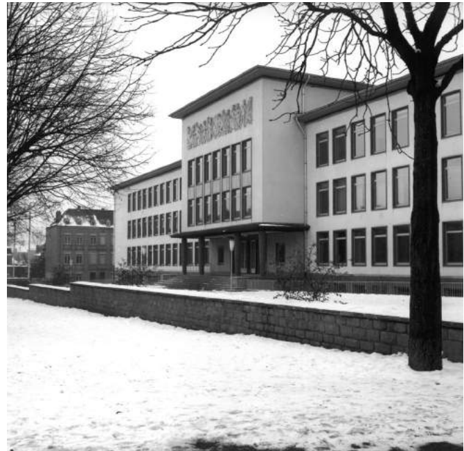
Abb. 151 Hauptfassade nach Fertigstellung
