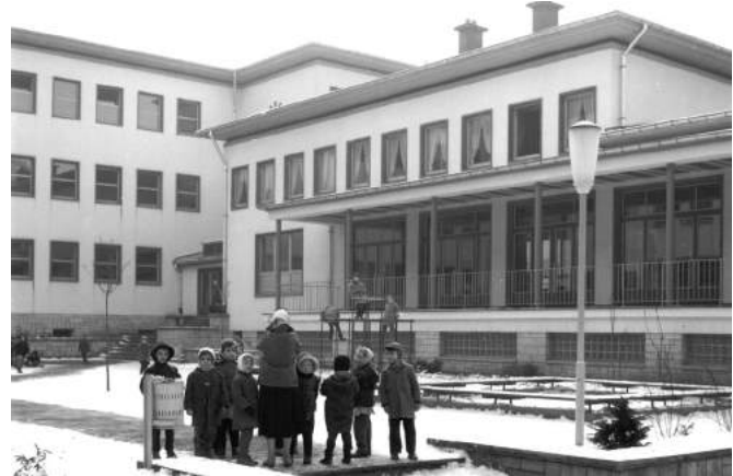
Abb. 159 Linker Flügel, hofseitige Nordfassade
