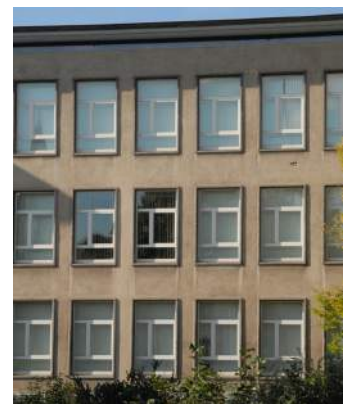
Abb. 219 Europäische Schule mit typischer Lochfassade (ausgewechselte Fenstern)
