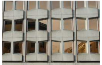
Abb. 222 Polizeikommissariat mit Fertigteilenelementen
