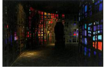
Abb. 257 Betonglas in der Krypta des Denkmal der nationalen Solidarität
