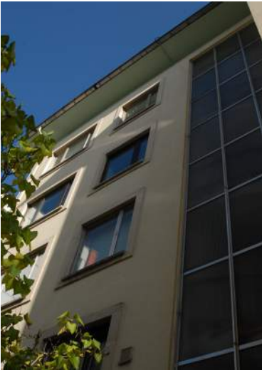
Abb. 56 Westfassade mit Treppenhaus (2014)
