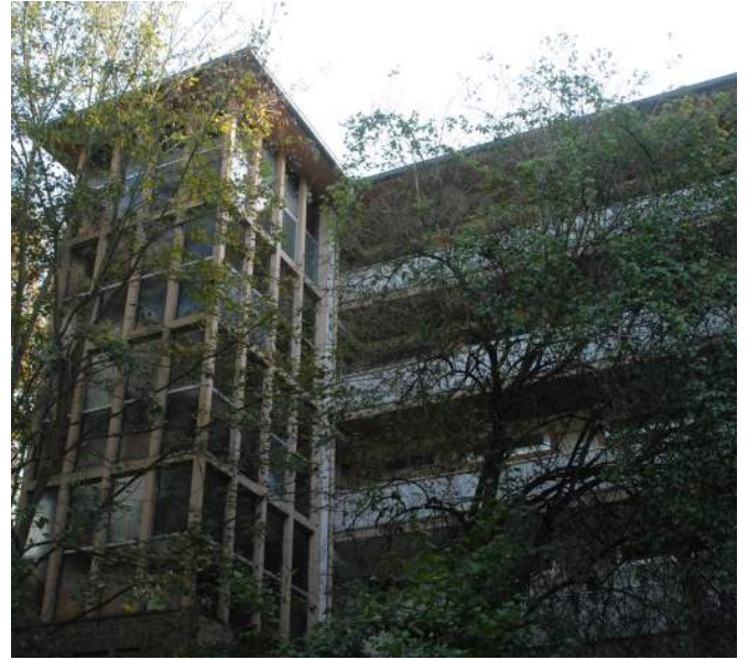
Abb. 48 Nordfassade mit Treppenturm und Laubengängen (2014)
