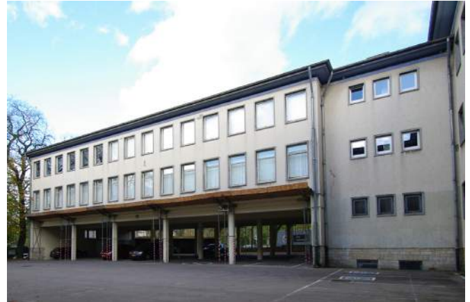
Abb. 161 Rechter Flügel, hofseitige Südfassade (2013)
