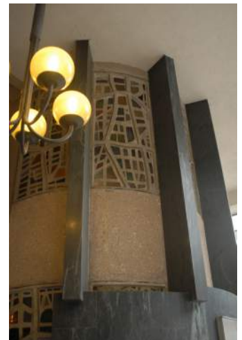
Abb. 256 Betonglas im Außenraum am Treppenhaus des Centre Louvigny
