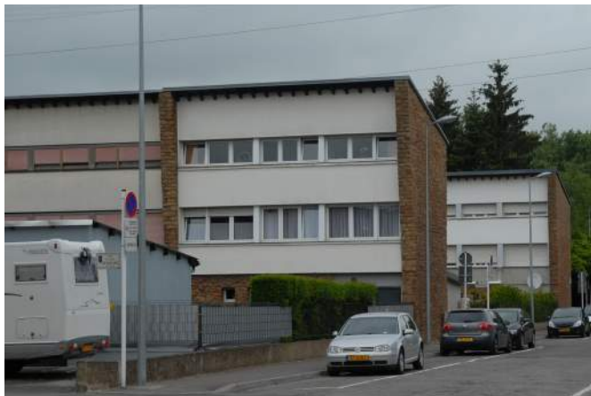
Abb. 83 Südlich orientierte Gartenfassaden (2015)
