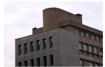
Abb. 210 Dachgeschoß des Centre Louvigny mit skulptural austretendem Treppenkern
