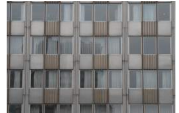
Abb. 215 Banque Général mit Skelettfassade und Betonung des vertikalen Rasters
