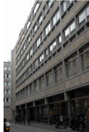
Abb. 124 Fassade Rue Louvigny
