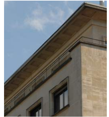
Abb. 208 Dachterrasse und Flugdach mit Untersicht am Bürogebäude Sogéco
