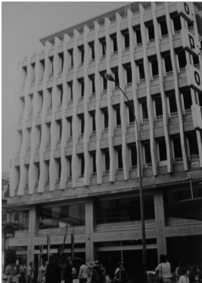
Abb. 140 Fassade Grand-Rue nach Fertigstellung
