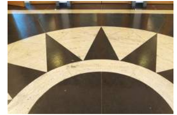
Abb. 262 Bodenbelag mit kombinierten Steinplatten in der Europäischen Schule
