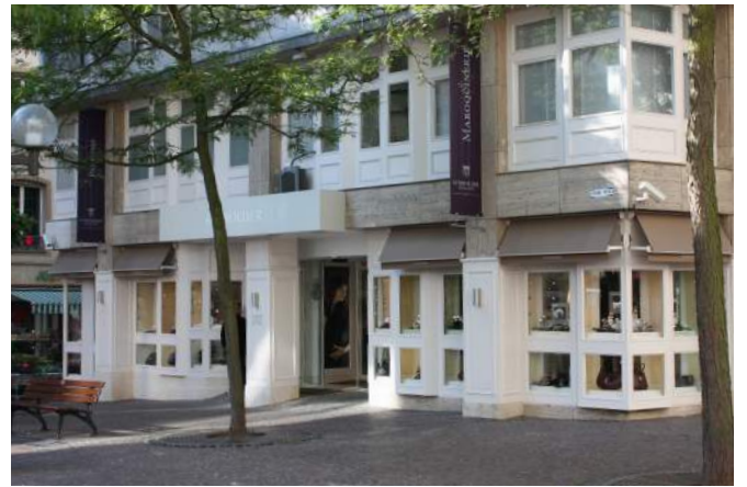
Abb. 143 Geschäftszone nach dem Umbau 2006 (2010)
