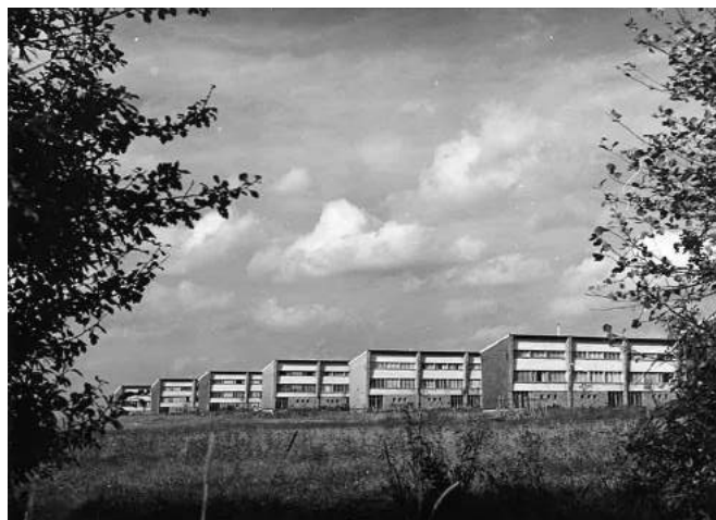
Abb. 78 Aufnahme nach Fertigstellung der Cité Eugène Reichling
