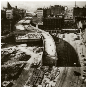
Abb. 115 Baustelle Stadtautobahn, Boston, 1933
