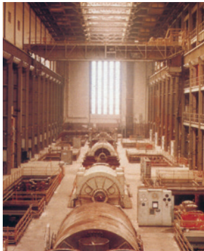
Abb. 41 Alte Turbinenhalle vor dem Umbau zur Tate Modern, London, 1994
