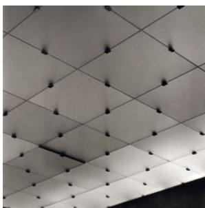
Abb. 169 Peter Zumthor, Untersicht Glasdecke, 1997
