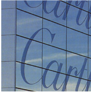
Abb. 82 Jean Nouvel, Lagergebäude Cartier, Fribourg, 1990
