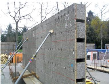
Abb. 17: Montage eines Mantelbetonwandelements
