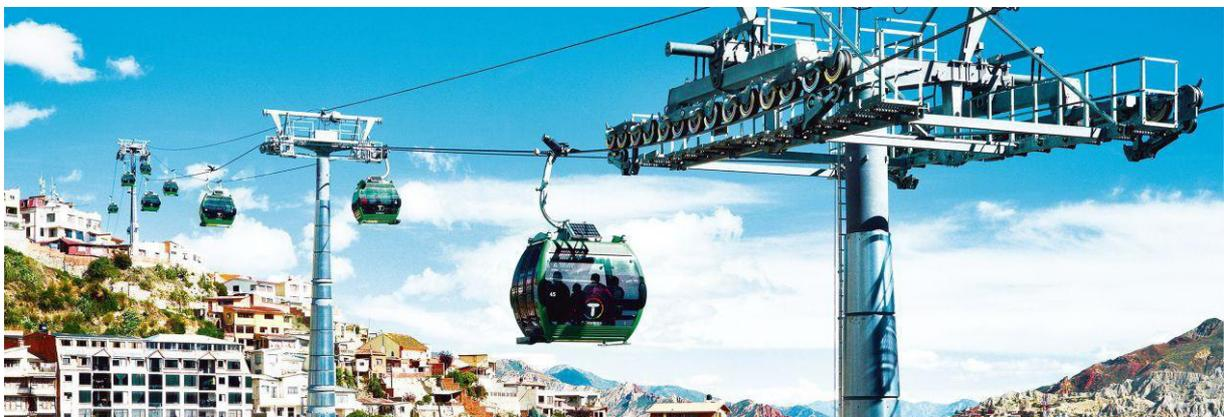
Abbildung 2.2: Einseilumlaufbahn, La Paz (Quelle: Doppelmayr, 2016a.)
