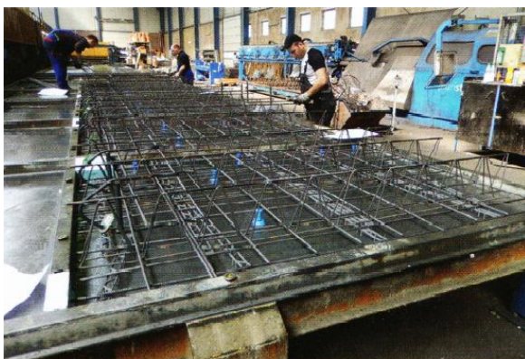
Abb. 5.12: Verlegte Bewehrung [HOH16]
