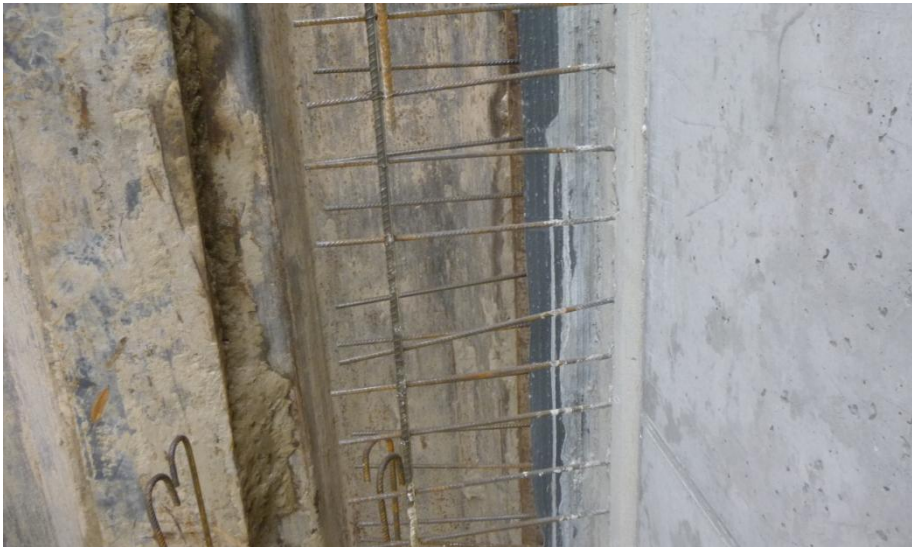
Abb. 6.42: Vertikale Arbeitsfuge mit innenliegendem Fugenband [HÜB16]
