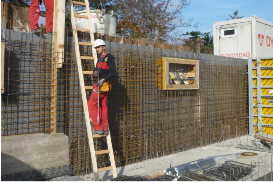
Abb. 6.41: Abschalen einer Arbeitsfuge [HÜB16]
