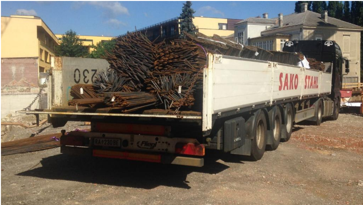
Abb. 7.16: Anlieferung von Bewehrungsstahl [HÜB16]
