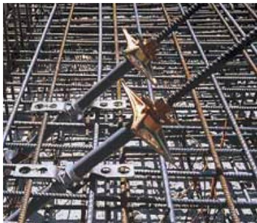
Abb. 6.29: Zuganker in der Fundamentplatte [PAS16]
