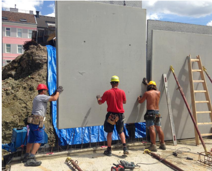
Abb. 6.13: Versetzen einer Elementwand [HÜB16]
