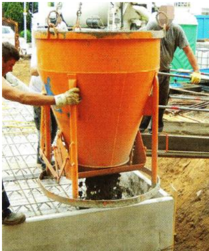
Abb. 6.24: Betonieren mittels Krankübel [HOH16]
