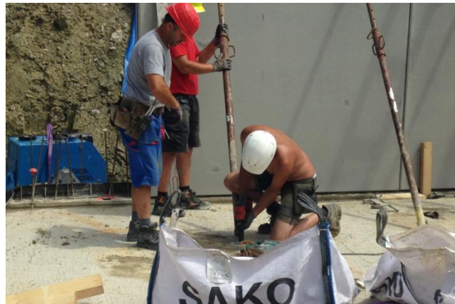
Abb. 6.15: Befestigung Schrägstützenfuß [HÜB16]
