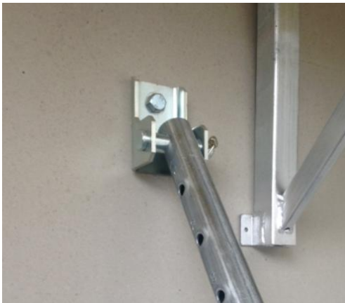
Abb. 6.14: Schrägstützenkopf [HÜB16]
