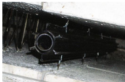
Abb. 6.21: Befestigung Dichtrohr [HOH16]
