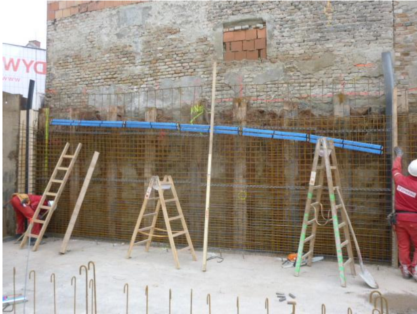
Abb. 6.35: Bewehrung vor einem Bohrträgerverbau mit Spritzbetonsicherung [HÜB16]
