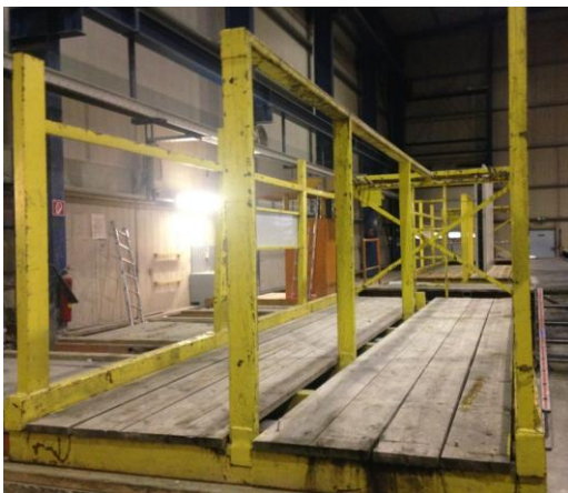
Abb. 5.25: Transportbox im FT-Werk [HÜB16]
