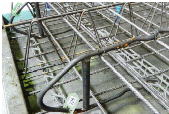
Abb. 5.13: Eingebaute Traganker [HOH16]
