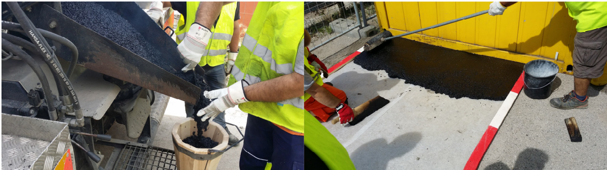
Abbildung 7: Händischer Einbau von Gussasphalt
