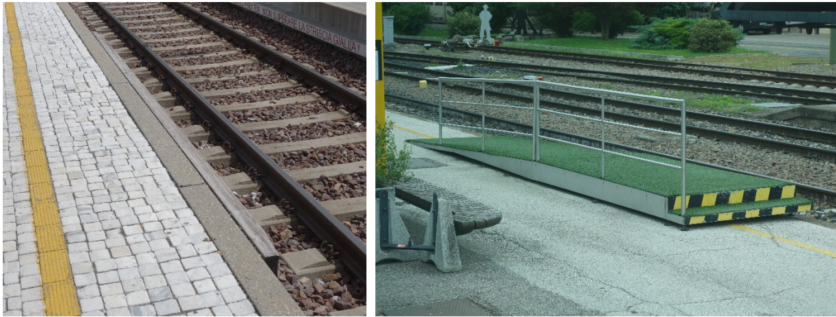
Abbildung 3-12: Links: Angeschraubte Holzleisten am Bahnsteig in Laas (Bstg.-Pflasterung aus Laaser Marmor). Rechts: Zugangsrampe am Bahnhof Meran. Quelle: Tomberger 2016.
