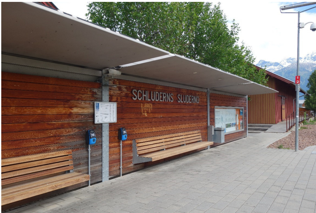
Abbildung 3-11: Neu errichteter Wartebereich mit Überdachung am Bahnhof Schluderns - Glurns. Quelle: Tomberger 2016.
