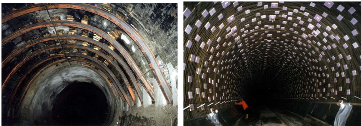
Abbildung 3-9: Josefsbergtunnel vor und nach der Sanierung. Quelle: GMK Bauingenieurbüro. http://www.gmk.bz.it/de/ref401.htm# .
