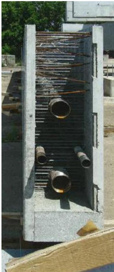
Abb. 3.8: Halbfertigteilträger mit Doppelwandelementen [6]
