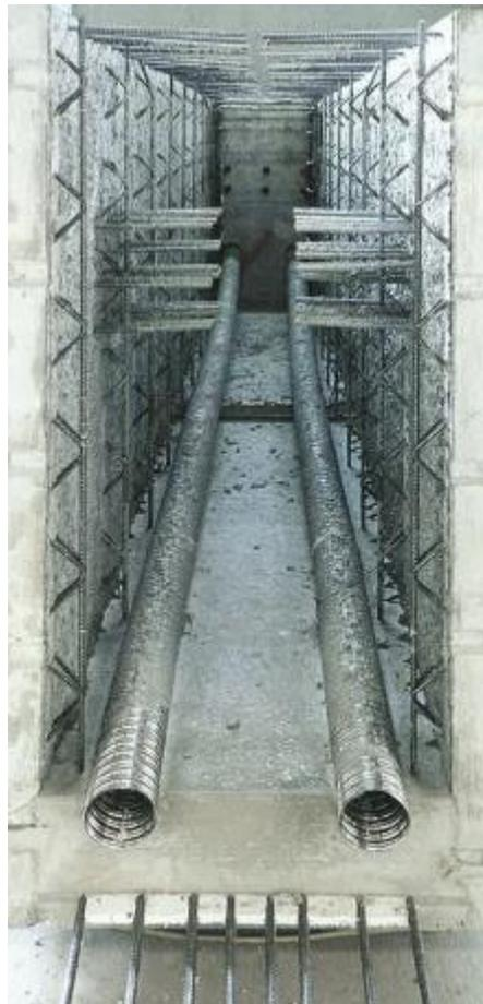
**Abb. 3.7: Halbfertigteilträger mit Gitterträgerdecken [6]**
