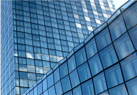
Abb.267: leicht bombierte Glasfassade
