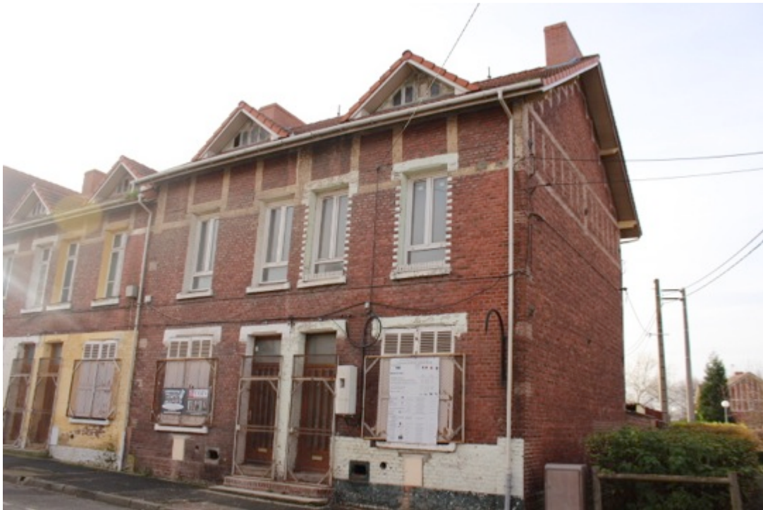
Abb. 34 Ein Haus, das im Rahmen von Rehafutur 2 saniert wird (eigenes Foto)
