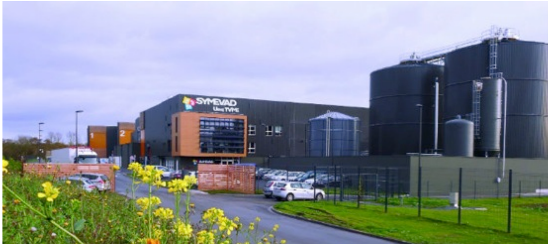
Abb. 27 Die Anlage für die Material- und Energieverwertung (Symevad,2016)
