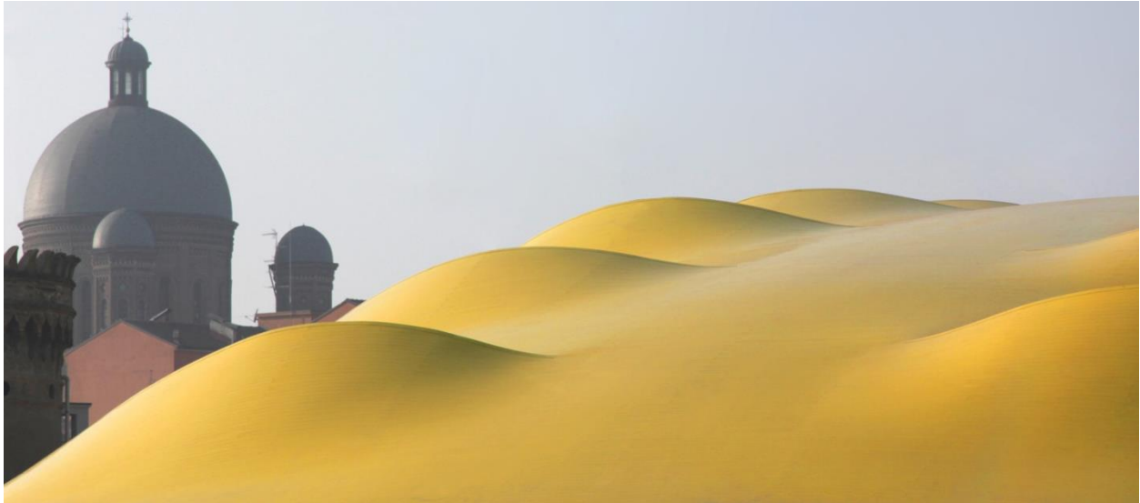
ABBILDUNG 1-3: DETAIL DES DACHES DES FERRARI MUSEUM IN MODENA [3]
