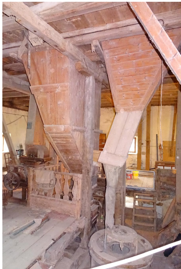
Abb. 194: Reserven des Mahlgangs und des Walzenstuhls
