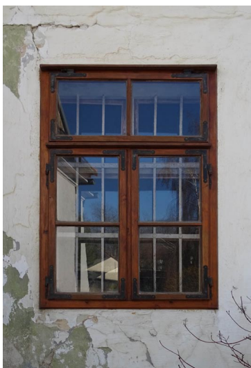
Abb. 4: Fenster beim alten Mühlenbau
