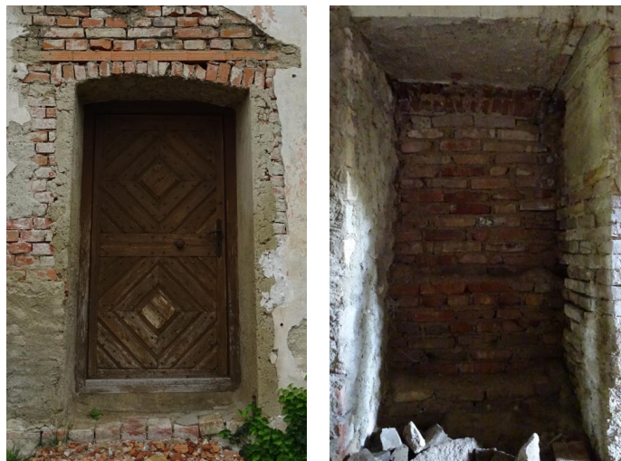
Abb. 319: Jetziger Eingang EG und früherer Eingang UG
