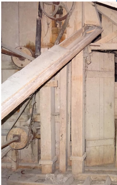
Abb. 282: Fallrohr am Elevator
