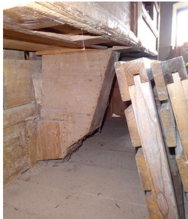
Abb. 246: Verbindung der Lüftung
