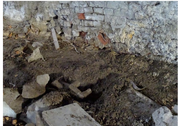
Abb. 165: Lage zum zugemauerten Durchbruch
