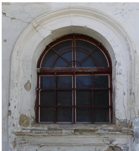
Abb. 5: Rundbogenfenster beim Zubau
