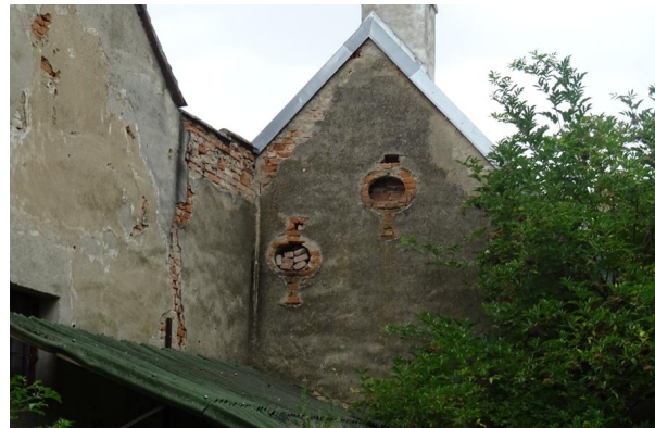
Abb. 19: Öffnungen im Wirtschaftsgebäude
