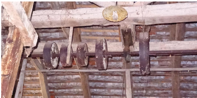
Abb. 171: Transmissionswelle im Reinigungsboden
