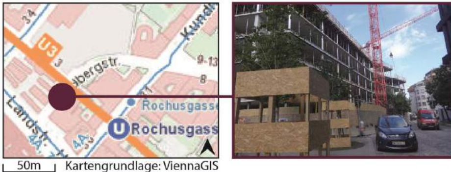
Abbildung 51: Negative Stelle: Baustelle (Erdbergstraße/Rochusmarkt)
