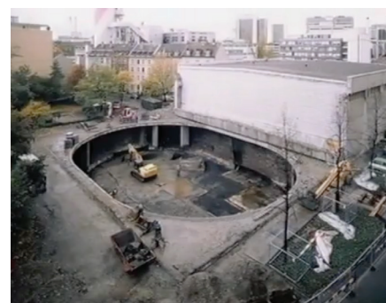
Abb. 17 Baugrube des ehemaligen Schweröltanks
