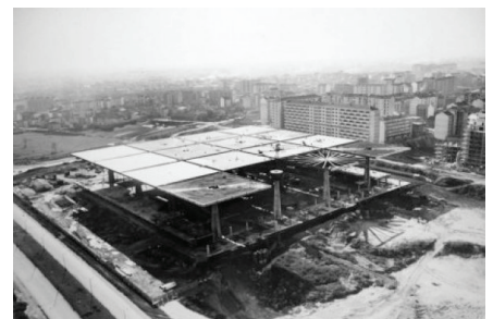
Abb. 3 Luftbild vom Fortgang der Bauarbeiten kurz vor Abschluss, Palazzo del Lavoro
