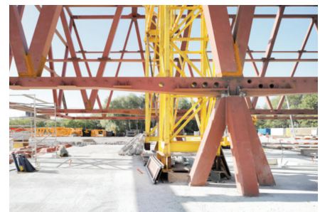
Abb. 11 Stahlfachwerk mit geplanten Öffnungen für Installationsleitungen
